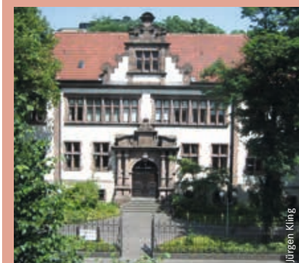
Das Haus der Stiftungen in NRW ist ein ehemaliges Offizierskasino der Ulanen. Es steht heute unter Denkmalschutz.
