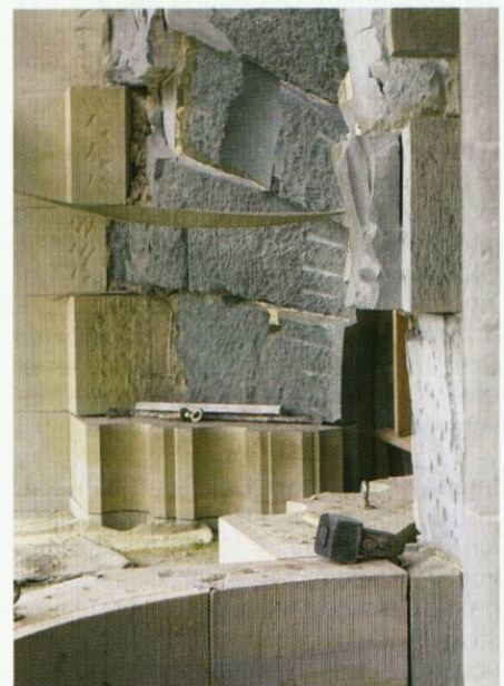
Alt und neu: Beim Wiederaufbau des Turm-Treppenturms nach der Tradition der mittelalterlichen Baumeister stößt Oberkirchener (hell) auf alten Soester Sandstein (grün).
