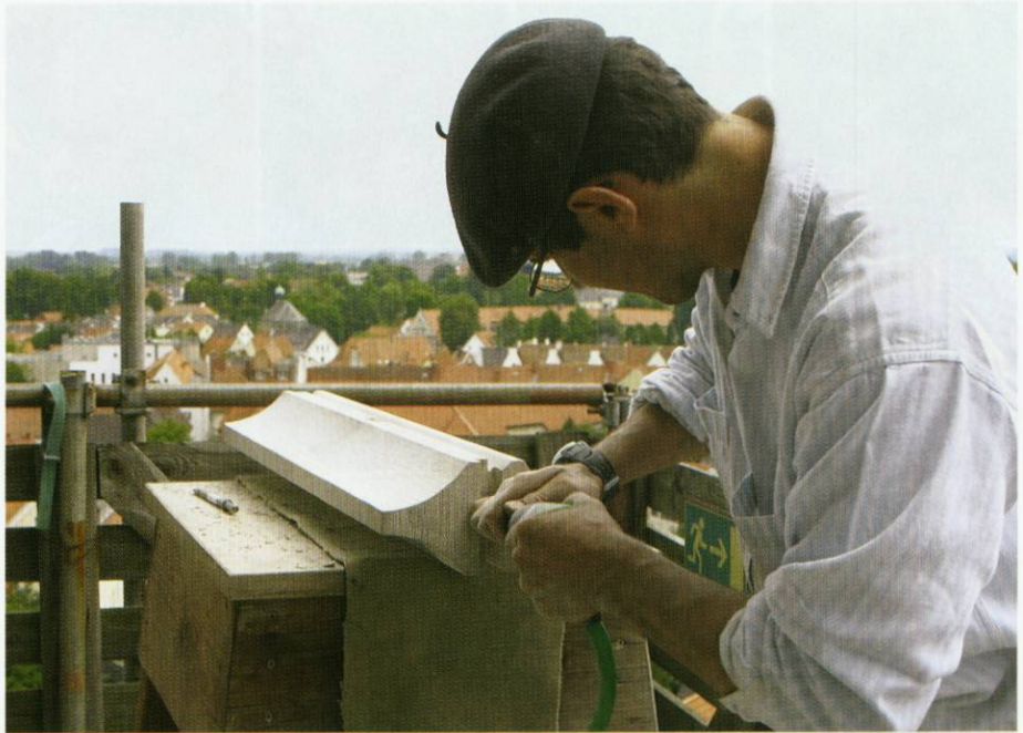
Luftiger Arbeitsplatz mit guter Aussicht. Für den Steinmetz Roland Mitzlaff (Bild), der hier an einem Teil des neuen Maßwerks eines Fensters arbeitet, ist der Blick über die Dächer von Soest Alltag und kein Grund mehr, die Arbeit zu unterbrechen.
