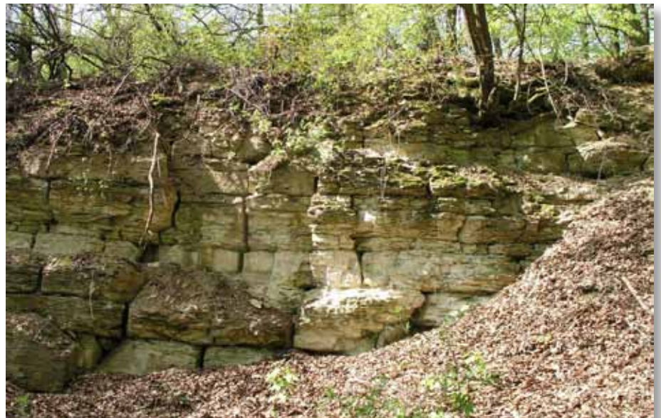
Ehemaliger Steinbruch im Bimbergtal: „Plänerkalkstein“ mit deutlich erweiterten Klüften
