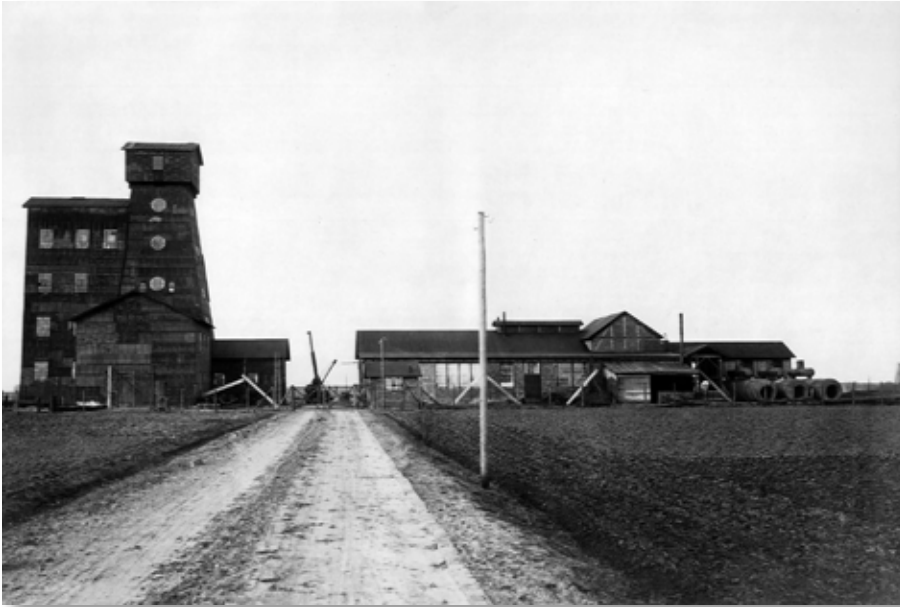
Abteufgerüst von Schacht Friedrichsfeld bei Wesel, 1914 (Sammlung W. Schubert/ D. Thiel, Moers) (aus: Salz und Sole im GeoPark Ruhrgebiet; GeoPark Themen Nr. 7; 2014)
