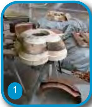
Dazu gehörte es, den maroden alten „Kaiser“ durch einen neuen zu ersetzen. Das Anfertigen des neuen Kaisers aus Kupfer erfolgte durch einen Mitarbeiter der Dachdeckerfirma, und zwar in reiner Handarbeit (Abb. 1).
