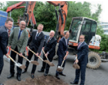
SPATENSTICH FÜR DIE ZUE AN DER STRESEMANNALLEE
