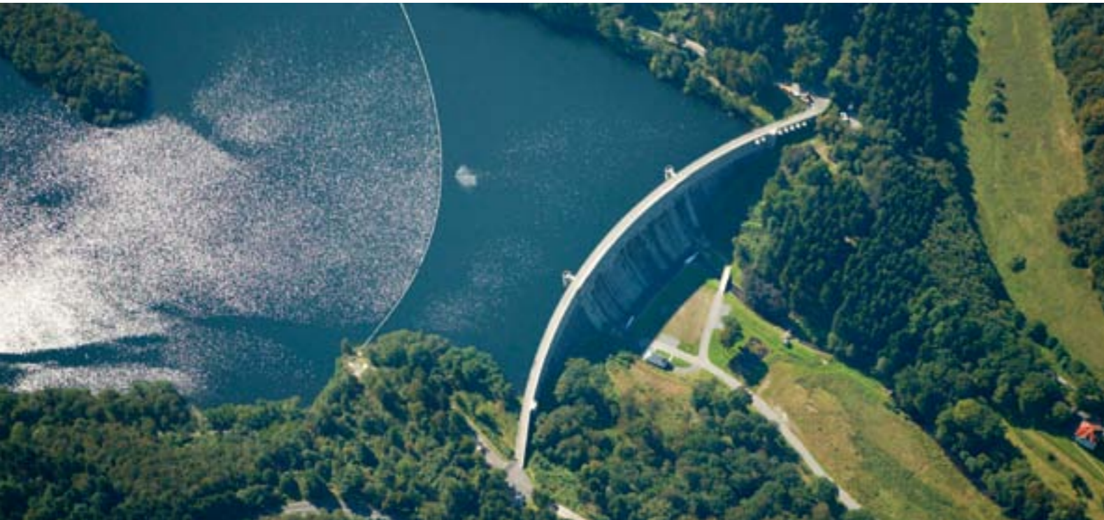
Blick auf die Staumauer der Ennepetalsperre.
