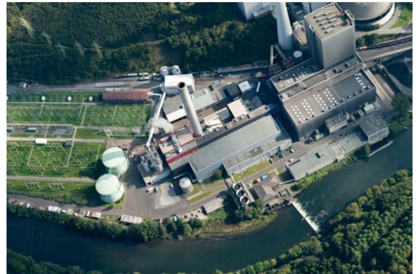
Wirbelschichtfeuerungsanlage Elverlingsen (WFA E)
