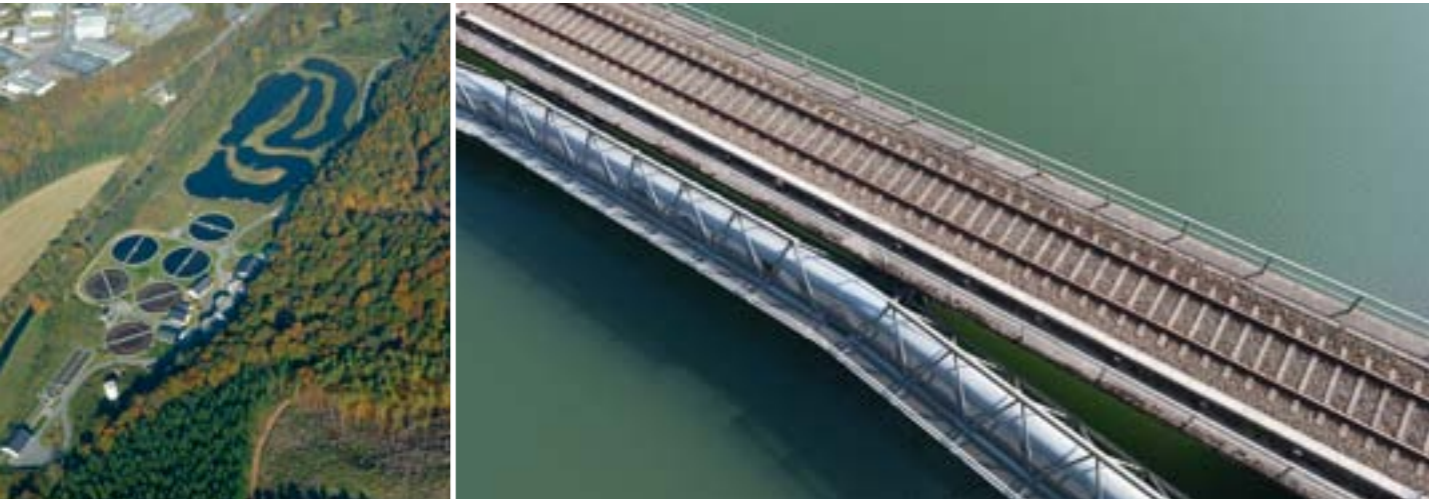
Der Biggerandkanal (r.) ist das Hauptzuleitungssystem der Kläranlage Biggetal (l.).
