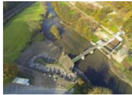
Ein naturnahes Gerinne an der linken Wehrseite dient den Fischen als Aufstiegshilfe.
