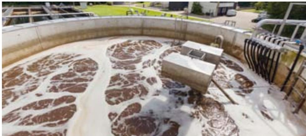
Die neue Schlammwasserbehandlungsanlage auf der Kläranlage Hemer funktioniert nach dem Prinzip der Deammonifikation.
