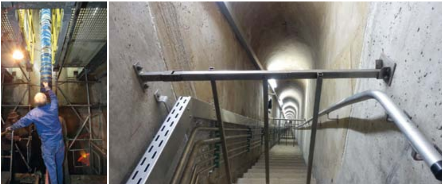
Über den Belüftungsschacht der Hochwasserentlastung wurde der neue Hydraulikzylinder hinabgelassen und montiert (l.). Ein steiler Abgang führt zum Segmentschütz hinab (r.).
