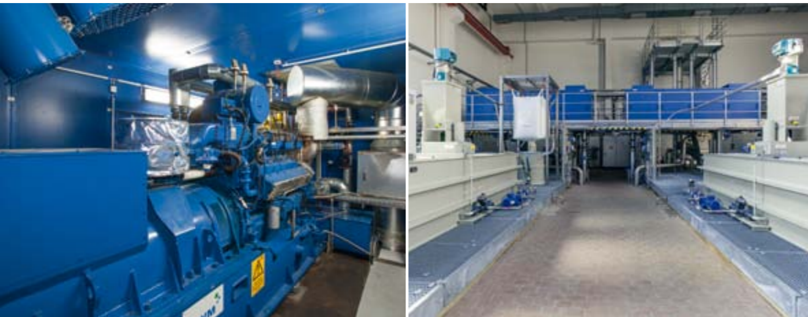
Leistungsstärkere BHKWs (l.) und neue Zentrifugen (r.) wurden auf der Kläranlage Duisburg-Kaßlerfeld installiert.
