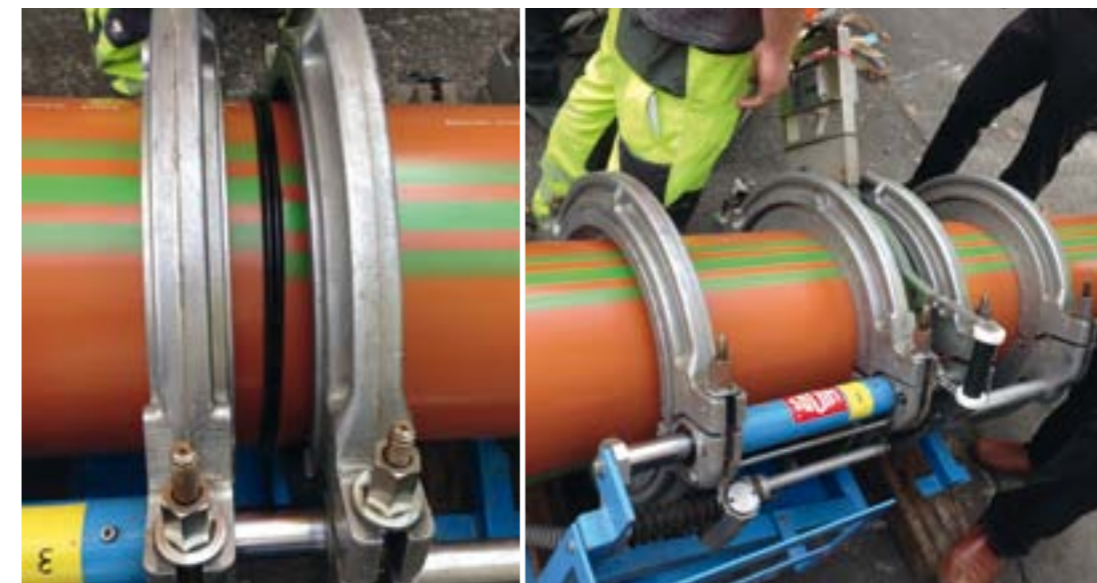
Einzug des Inliners (l.), Verschweißung der neuen Rohrleitung (r.)
