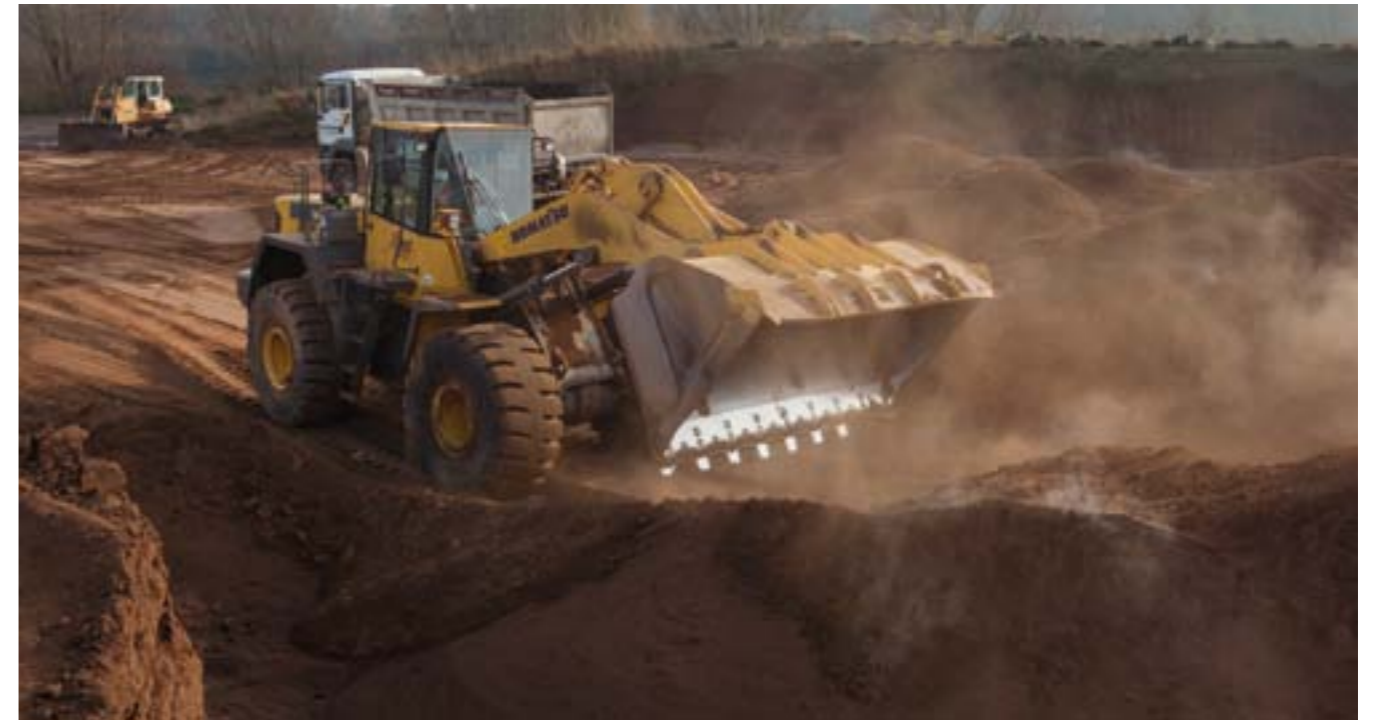
Die Deponie Mülheim-Raffelberg wurde bis 2009 verfüllt. Der Ruhrverband prüft die Möglichkeit, an diesem Standort eine Monodeponie für Klärschlammmasche zu errichten.
