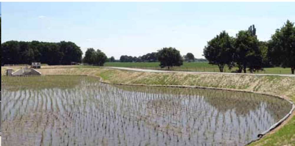
Der neue Retentionsbodenfilter auf der Betriebsstelle Vernum
