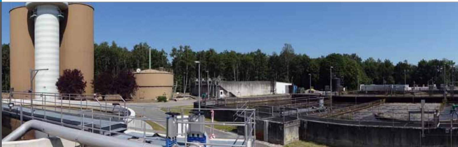
Kläranlage Kevelaer-Weeze: Alte Anlagenteile und neue Erweiterung
