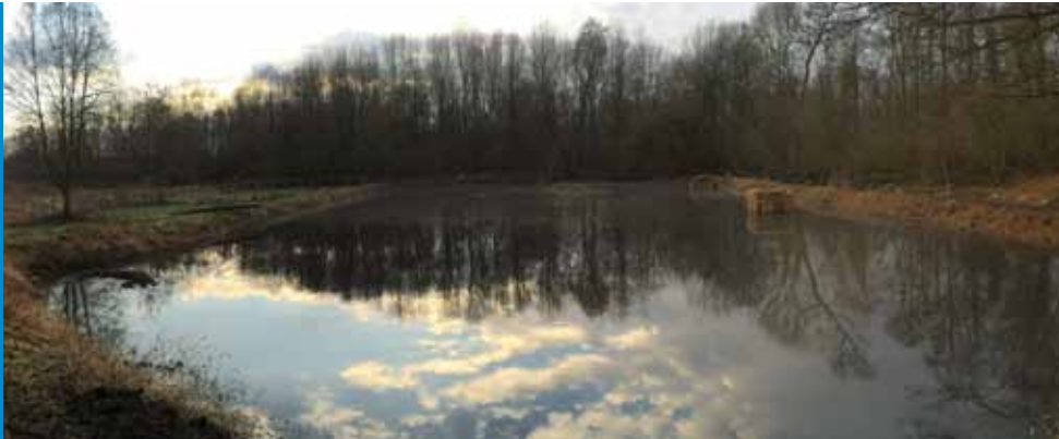
Hochwasserrückhaltebecken Odenkirchen: Absetzbecken bei der Befüllung mit Schlamm
