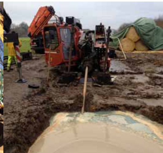
Verlegung der Rohrleitungen im Spülbohrverfahren
