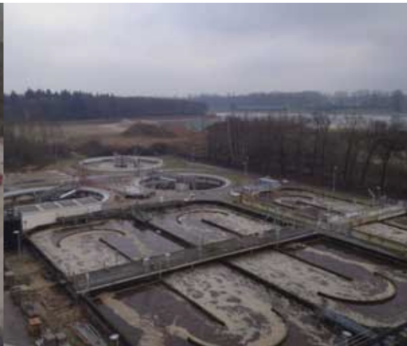
Erweiterung der biologischen Reinigungsstufe
