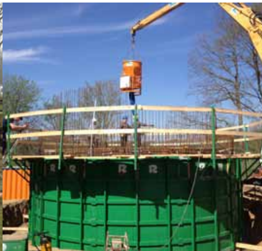
BST Tönisberg: Bau der Pumpstation
