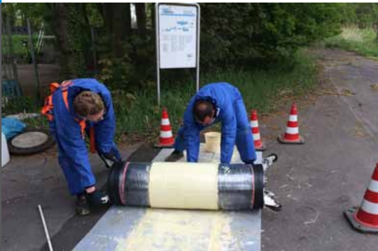
Betriebsstelle Kaldenkirchen: Vorbereitung des Partiniers für den Einbau
