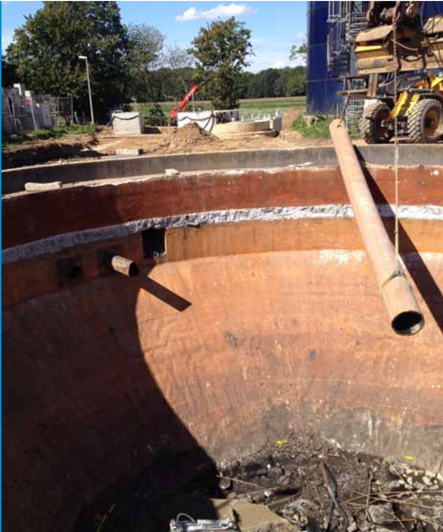
Bst. Tönisberg: Umbau des Denitrifikationsbeckens zum Speicherbecken mit Minibagger zur Erstellung einer ebenen Betonsohle
