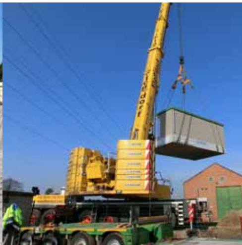
Anlieferung der Betonstation für die neue Schaltanlage
