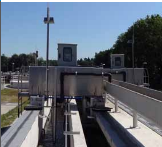
Der neue Sandfang auf der Kläranlage Kevelaer-Weeze
