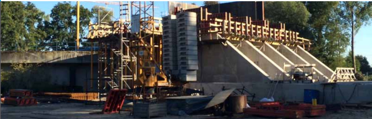
Regenwasserpumpwerk Süchteln während der Bauphase
