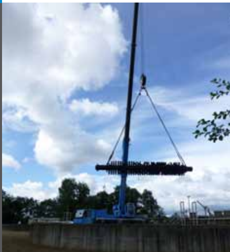
Kläranlage Sonsbeck: Bergung der Belüfterwalze
