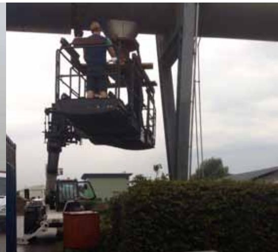
Installation der erweiterten Gebläsemietanlage
