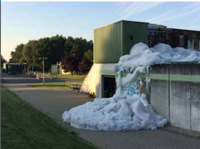
Kläranlage Grefrath: Schaumbildung infolge tensidhaltiger Abwässer
