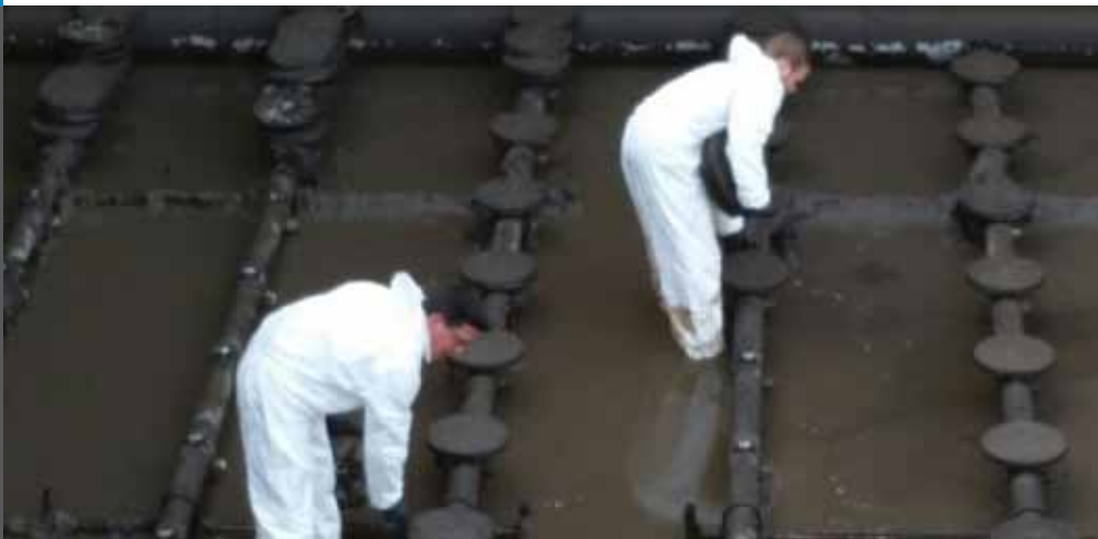
Belebungsbecken 25-27: Mitarbeiter beim Tellertausch
