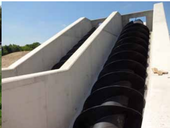
Betriebsstelle Vernum: Neues Zulauf-Schneckenpumpwerk
