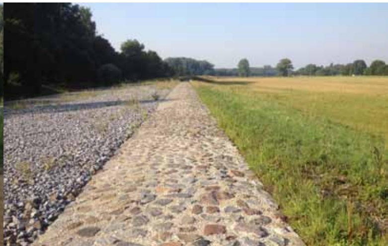
HRB Geneicken: Hochwasserentlastung
