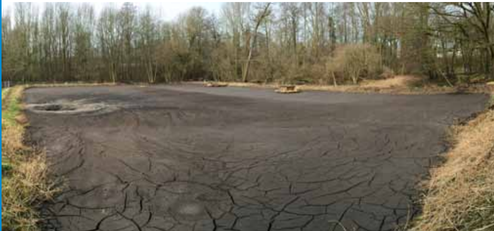
Absetzbecken mit getrocknetem Schlamm
