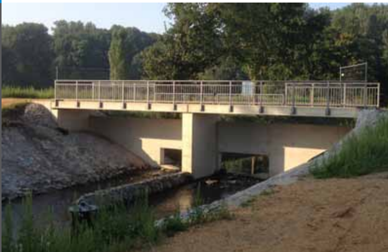
HRB Geneicken: Nierswehr mit den Schützöffnungen
