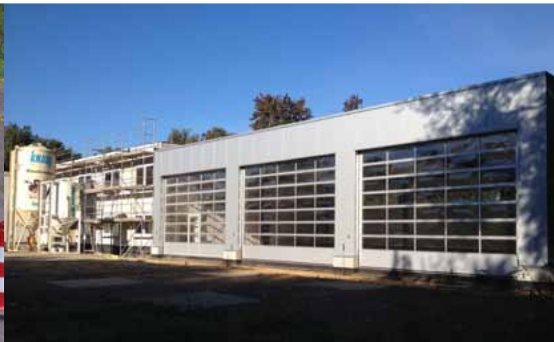
Bau des GL-Sozial- und Betriebsgebäudes mit zusätzlicher Gerätehalle in Grefrath
