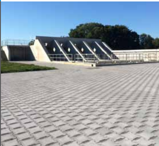
Betriebsstelle Dülkener Nette: Neues Schneckenhebewerk
