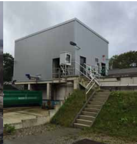
Neue Rechenhalle mit anschließendem Sand- und Fettfang
