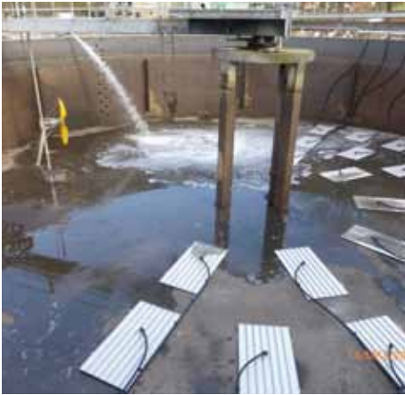
Kläranlage Walbeck – Einbau der Plattenbelüfter
