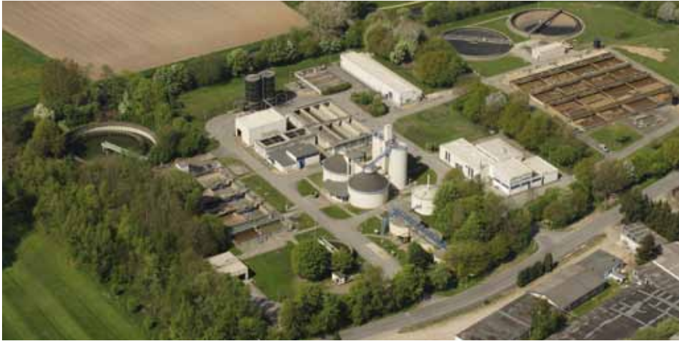
Luftbild der Kläranlage Goch
