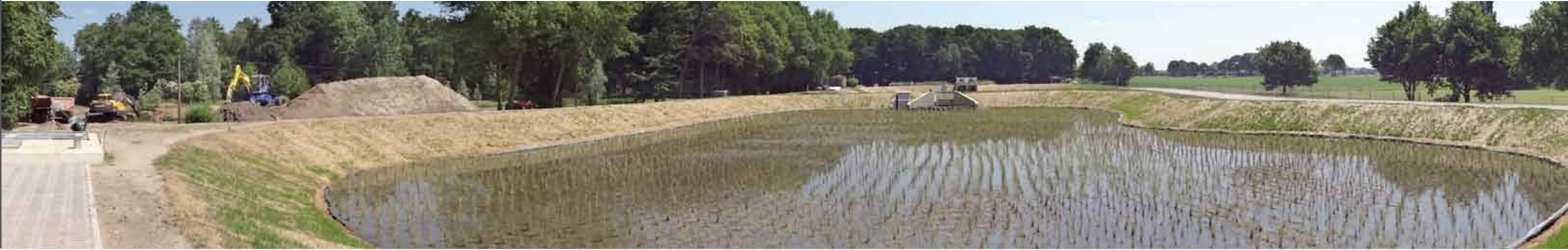
Der neue Retentionsbodenfiltern auf der Betriebsstelle Venum, links im Hintergrund die Gewässerbaumaßnahme an der Sevelener Landwehr
