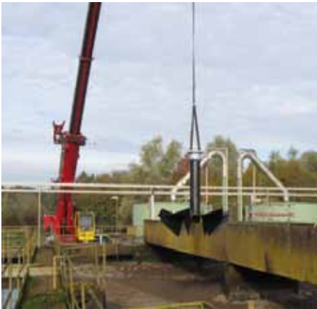
Kläranlage Dülken – Einbau der Oberflächenbelüfter
