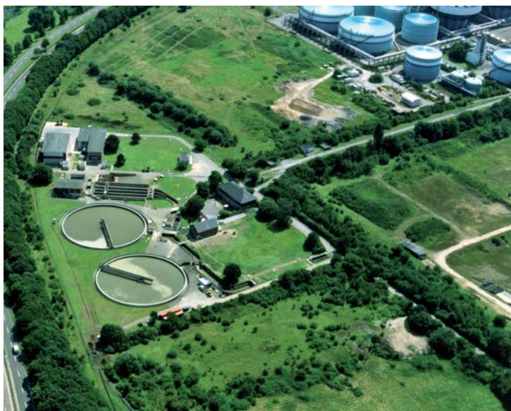
Kläranlage Leverkusen, links der Anlagenteil des Wupperverbandes
