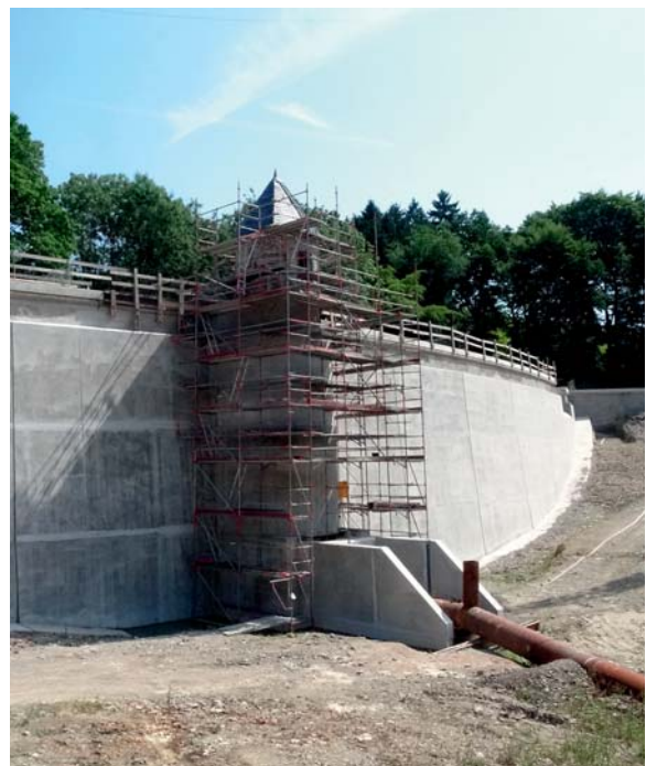
Panzer-Talsperre, sanierte Wasserseite der Staumauer
