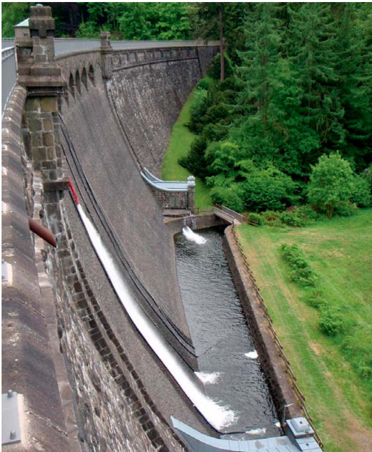
Neyetalsperre, Überleitung von Talsperrenwasser zum Neyebach
