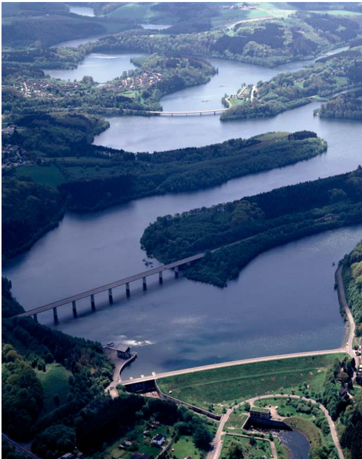
Die Wupper-Talsperre dient auch dem Hochwasserschutz.
