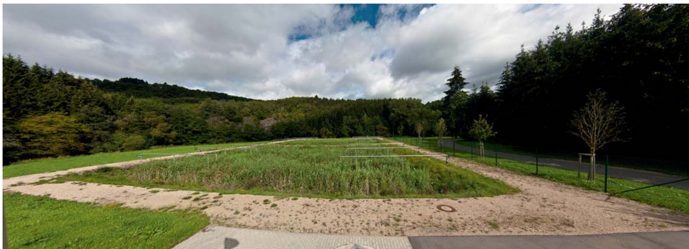
Bodenfilter Kläranlage Irsental
