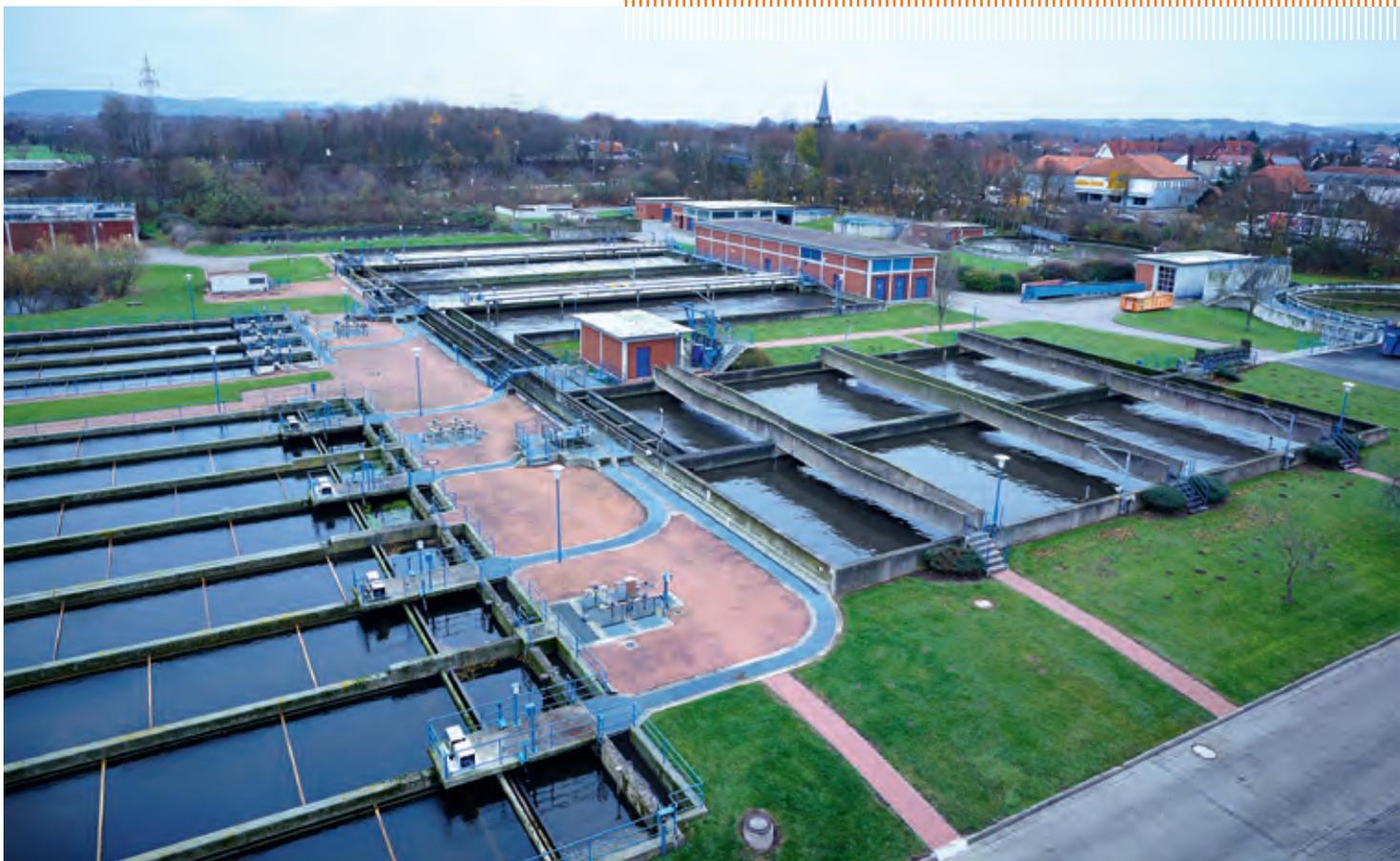
der unbelüfteten Becken reduziert. Dadurch wurde nicht nur das Problem der „Denitrifikation“ gelöst, gleichzeitig konnte der Energiebezug um rund 150.000 kWh jährlich gesenkt werden.
