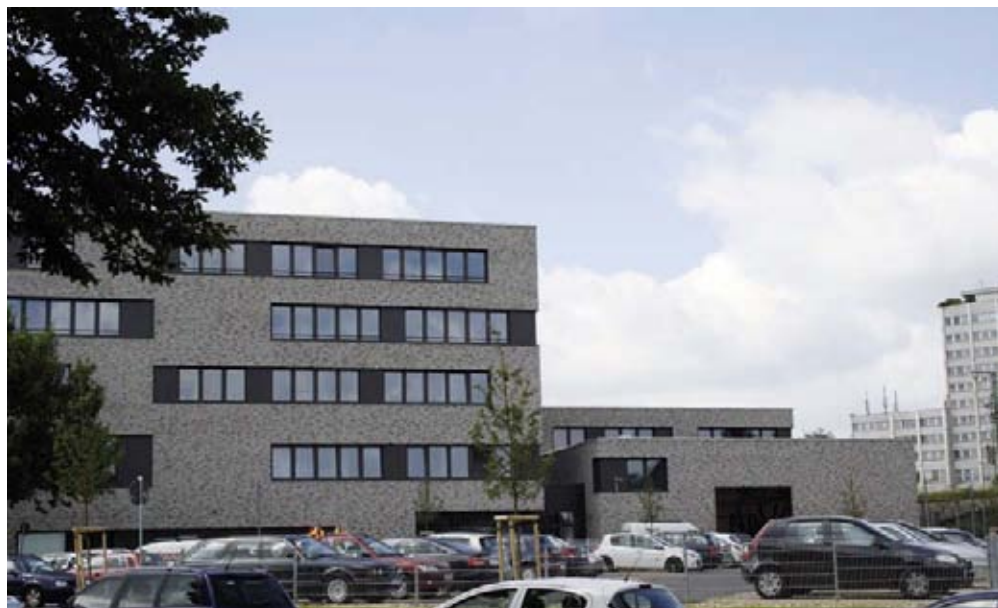
Der Neubau der Kreishandwerkerschaft am Platz des Handwerks.
