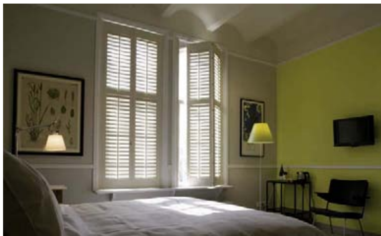
Innenfensterläden aus Holz sorgen im Sommer für angenehme Raumtemperaturen.
