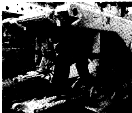
Trotz 14 Tonnen Gewicht bewegt sich der elektronisch gesteuerte Riese unter Tage als kluger Roboter in schwierigem Gebirge: Schildmontage für Strebaubau vor fünfzehn Jahren und Schild-Einfahren im Streb.
