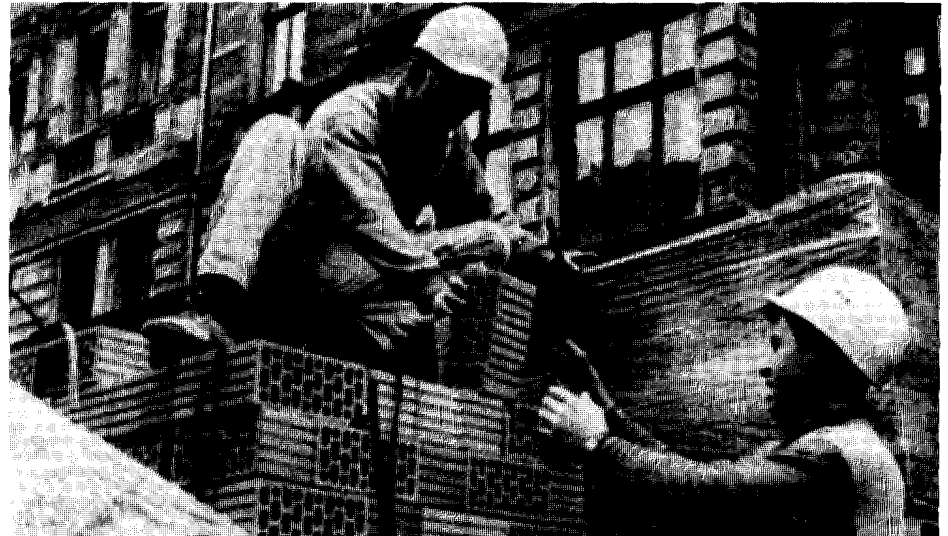
Massenhafte Billiglohnarbeit am Bau bedroht Arbeitsplätze in NRW.
