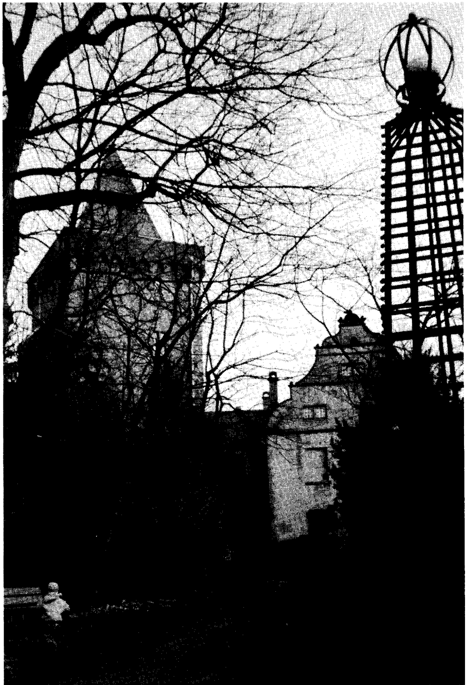
Umbaupläne gibt es für das idyllisch über dem Ruhrtal schon auf Ratinger Boden bei Kettwig gelegene Schloß Landsberg (Bild). Die Besitzerin, die Thyssen-Stiftung, will das Baudenkmal aus seinem Dornröschenschlaf wecken und zu einer Akademie für Führungskräfte umbauen. Dazu soll neben der ehemaligen Gärtnerei ein siebengeschossiger Wohnturm errichtet werden, wie aus ersten Plänen ersichtlich ist, die vor kurzem den befaßten örtlichen Stellen vorgelegt worden sind. Außerdem soll die alte Schloßanlage, die der im mächtigen Bergfried beigesetzte Konzerngründer August Thyssen 1903 gekauft und zu einem repräsentativen Industriellensitz umgebaut hatte, restauriert und modernisiert werden. Das Schloß, dessen Inneres und dessen Park für die Öffentlichkeit nicht zugänglich sind, ist beliebter Punkt bei vielen Wanderungen entlang der Ruhr. Naturfreunde fürchten bei Realisierung der Pläne um Ruhe und Erhalt der von tiefen Tälern zerklüfteten Umgebung; Denkmalschützer warten vor einem Urteil die Konkretisierung der Konzernpläne ab.
