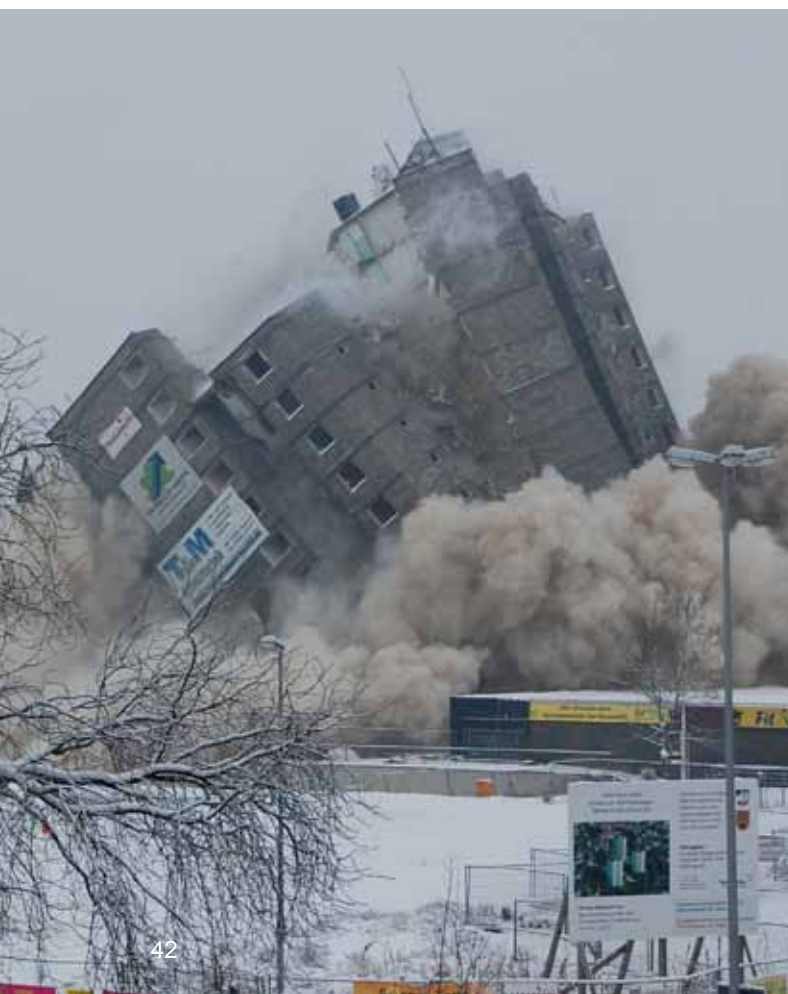
Sprengung der „Weißen Riesen“, Kamp-Lintfort
