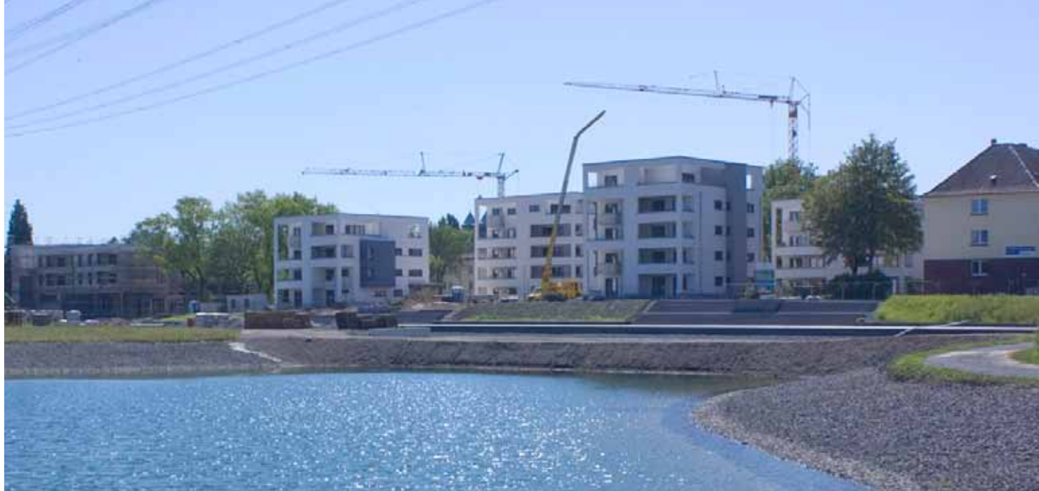
Uferviertel im Bau, Essen-Altendorf
