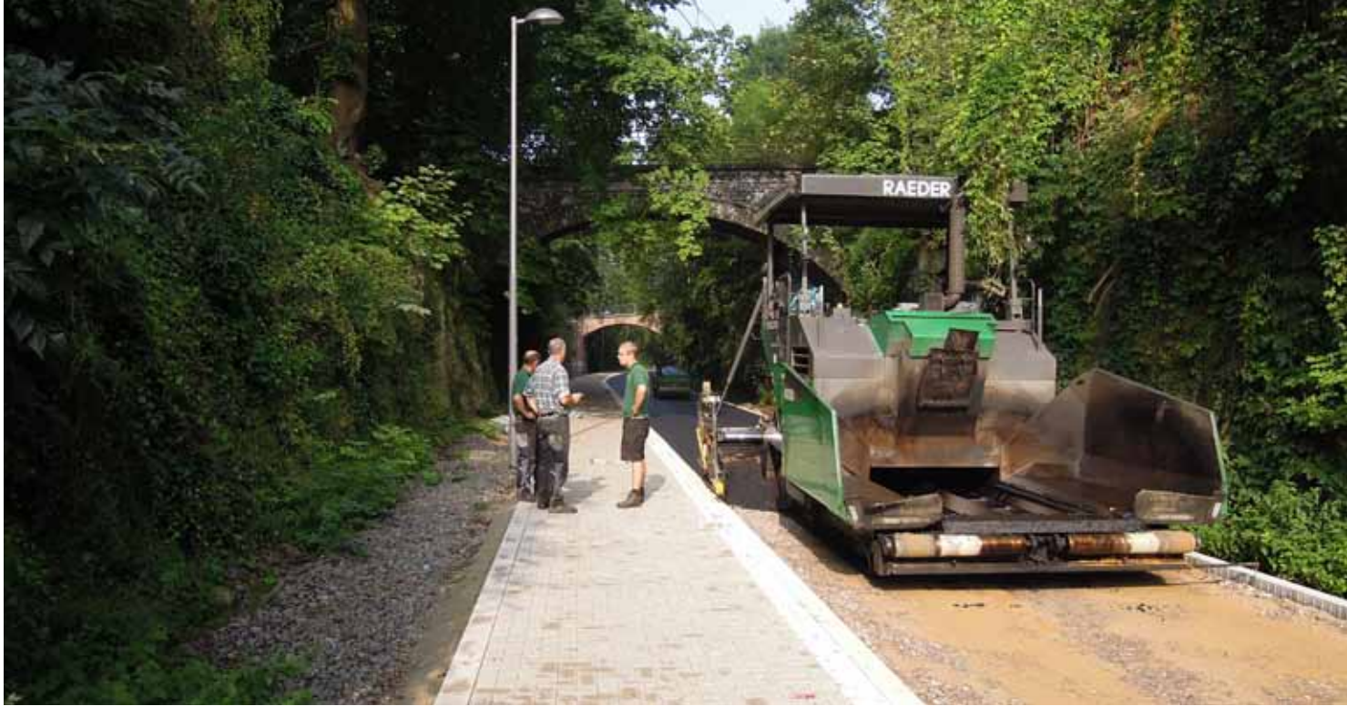
Bauarbeiten auf der Nordbahntrasse, Wuppertal
