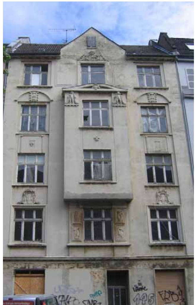
Problemimmobilie in der Nordstadt vor Baubeginn
