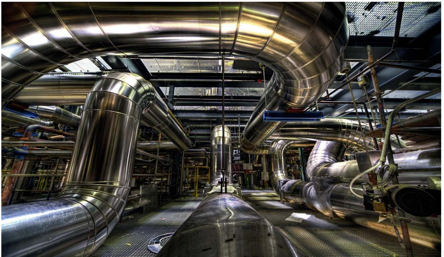
Energieeffizienz pur: Zur Eigenstromerzeugung leiten die Rohre im Gichtgaskraftwerk Dillingen die überschüssigen Hochofengase in Dampfturbinen.
