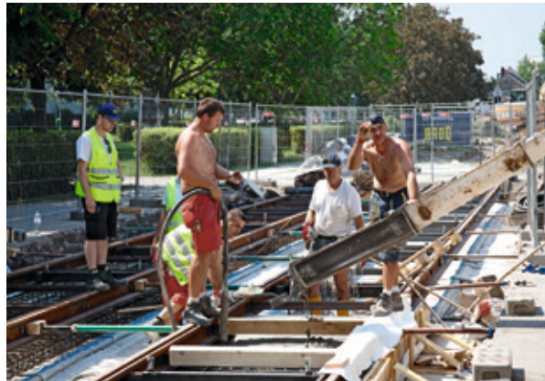
Abb. 10 Herstellung von Betonfeldern
