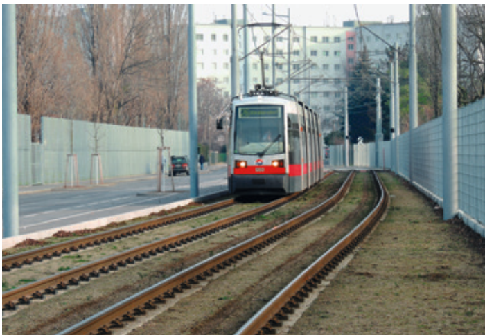
Abb. 5 Bauabschnitt 3: Grüngleis in der Oberfeldgasse
