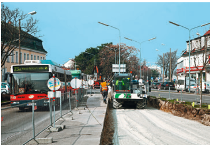
Abb. 9 Bauabschnitt 1: Zementstabilisierung im Bereich Kagraner Platz
