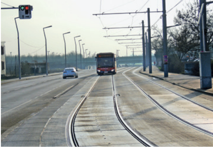
Abb. 7 Bauabschnitt 3: Selbstständiger Gleiskörper in der Hausfeldstraße
