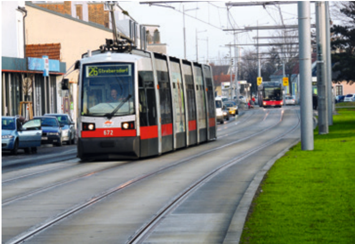
Abb. 3 Bauabschnitt 1: Selbstständiger Gleiskörper am Kagraner Platz
