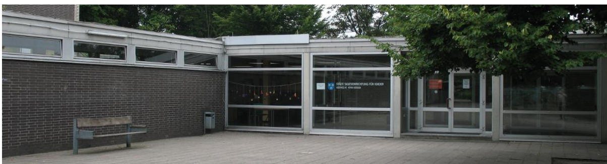
Abbildung 26: KiTa Heidweg Eingangsbereich 2 unsaniertes Zustand
