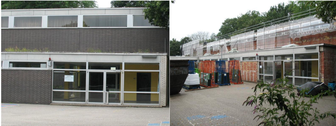
Abbildung 23: Grundschule Brüder Grimm im sanierungsbedürftigem Zustand und im Umbau
