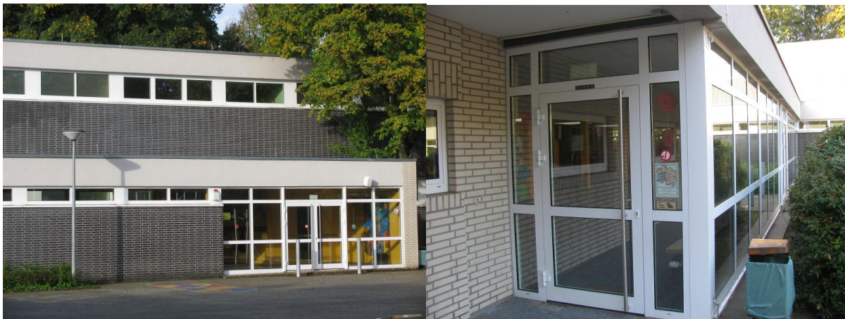
Abbildung 24: Grundschule Brüder Grimm im sanierten Zustand
