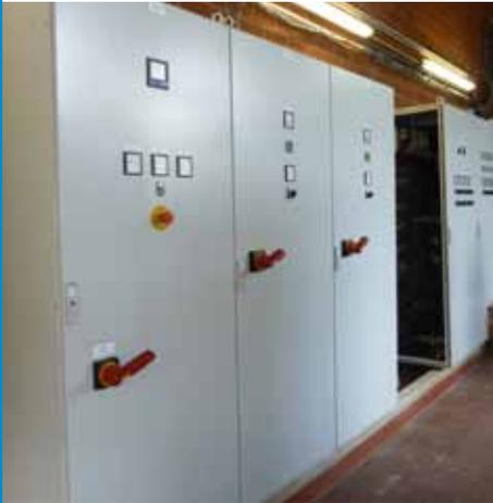
An der mehr als 15 Jahre alten Fällmittelstation traten zunehmend Störungen an der Dosier- und Elektrotechnik auf. Während die Elektrotechnik bereits letztes Jahr erneuert wurde, ist in diesem Jahr die Dosiertechnik dem Stand der Technik angepasst worden. Zusätzlich wurden weitere Arbeiten durchgeführt, um den VaWS- Anforderungen zu entsprechen.
