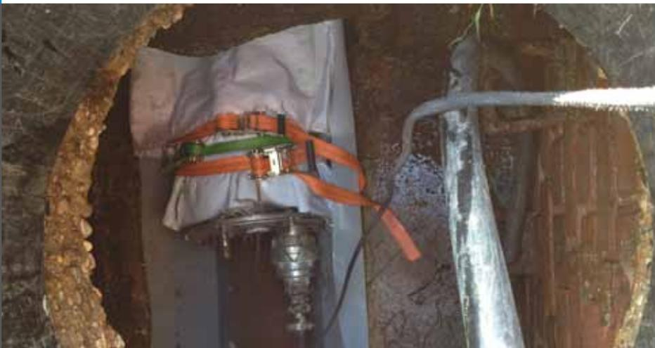
Einbau der UV-Lampenkette im Zielschacht
