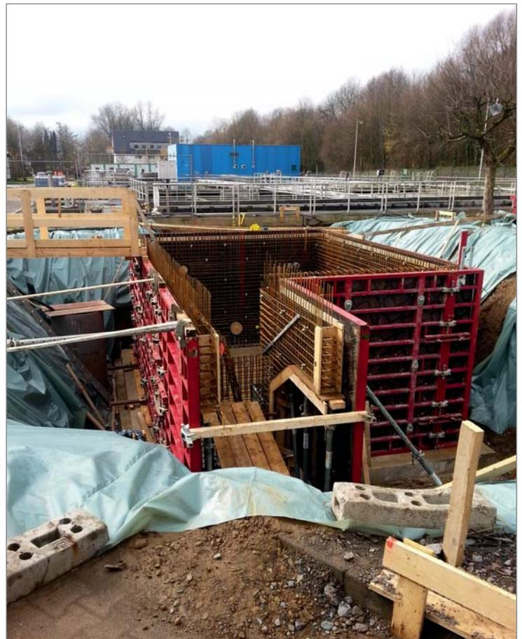
In der Kläranlage Buchenhofen hat der Wupperverband die biologische Reinigungsstufe überplant und setzt nun verfahrenstechnische Optimierungen um. Ziel ist die Steigerung der Energieeffizienz. Bei dem ganzheitlichen Ansatz wurden Hydraulik, ein geeignetes Belüftersystem, Leistungs- und Druckanpassung der Turboverdichter, die Anordnung des Belüftersystems und eine abgestimmte Regelstrategie berücksichtigt.
