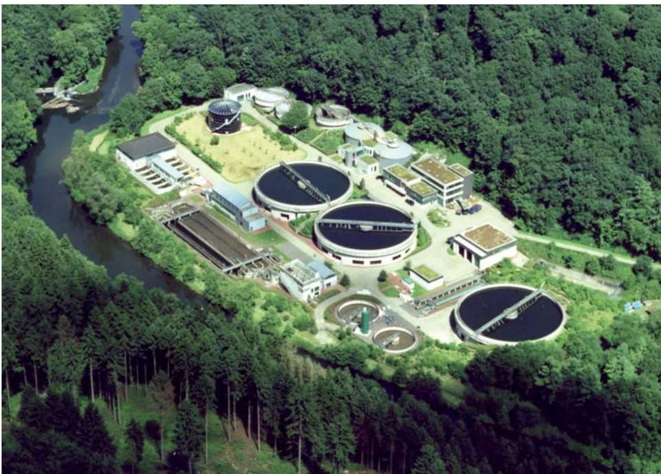
Das Projekt umfasst die Optimierung des Wasserwegs und der Schlammeindickung sowie den Bau einer neuen Lagerhalle. In 2014 wurden die Arbeiten für die Schlammbehandlung – Austausch der alten Zentrifugen gegen neue Bandeindicker mit geringerem Stromverbrauch – fertig gestellt.
