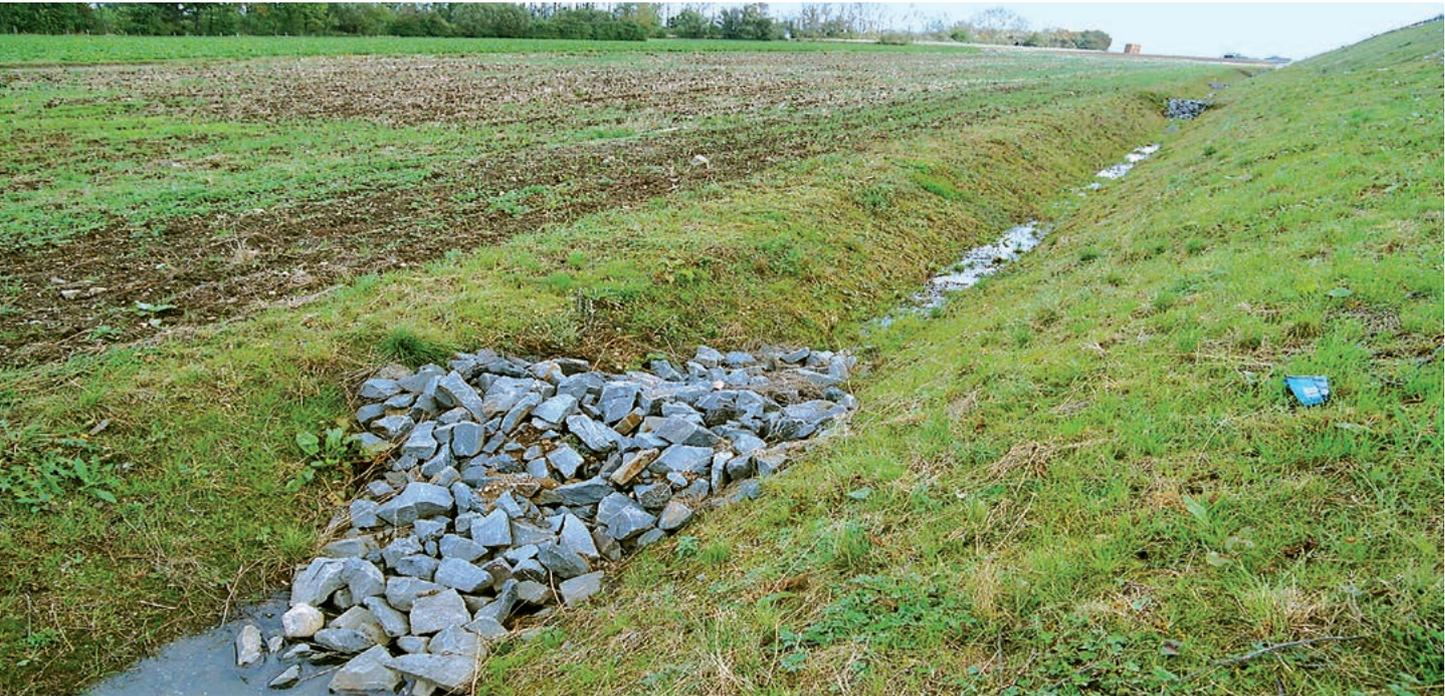
Bild 3.2: Straßenseitengraben mit durchlässigen Querriegeln am Böschungsfuß einer Autobahn (rechte Bildseite) (A1)
