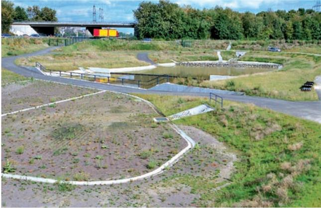
Bild 2.10: Versickerungsbecken (Vordergrund, Vegetationsdecke ist noch nicht voll ausgeprägt) mit punktuelltem Zulauf, Absetzbecken, Leichtstoffabscheider und breitflächigem Zulauf zum Becken (VA4)
