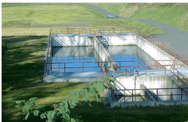
Bild 4.2: Abscheideanlage nach RiStWag
