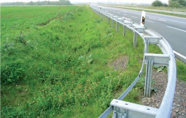
Bild 2.8: Mulden-Rigolen-Element als Linienelement im Straßenseitenraum (VA3)
