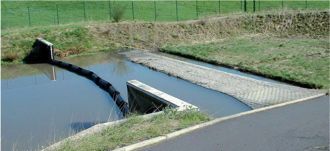
Bild 6.5: Bodenfilterfläche, Blick über die Vorstufe mit schwimmender Tauchwand auf die Filterfläche
