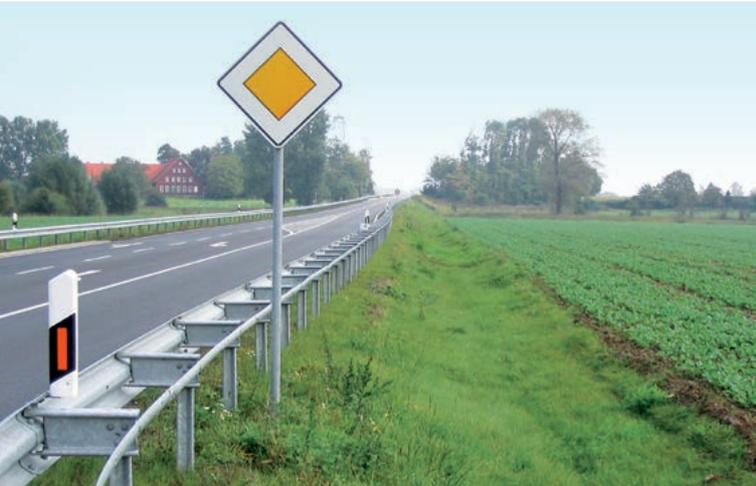
Bild 2.2: Großflächige Versickerung über die Böschung (VA1)
