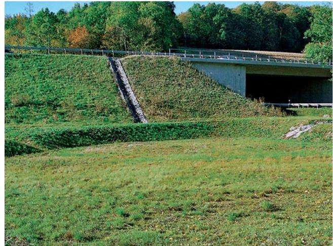
Bild 2.3: Großflächige Versickerung als dezentrale Versickerungsanlage mit punktuelltem Zulauf (rechter Bildrand) (VA1)
