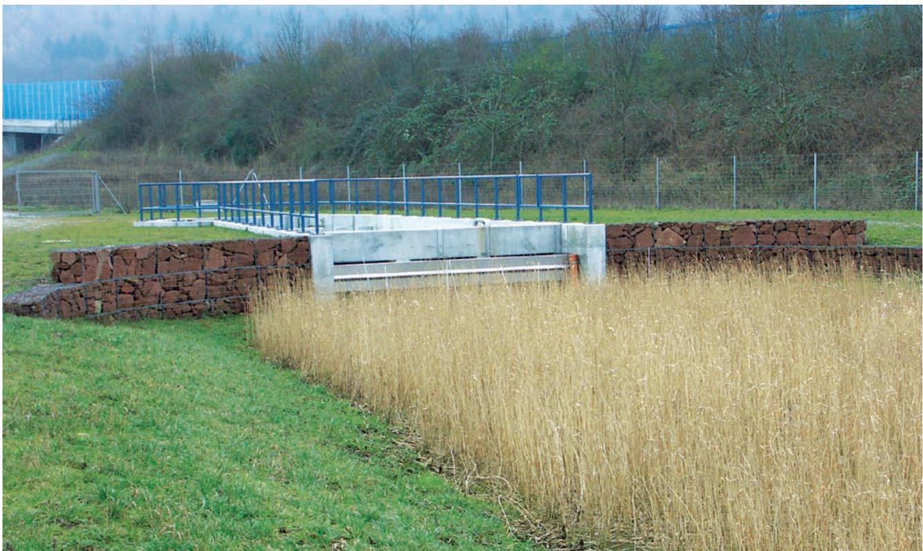
**Bild 6.2: Retentionsbodenfilteranlage, Blick auf Filter und Vorstufe (Roth 2005)**
