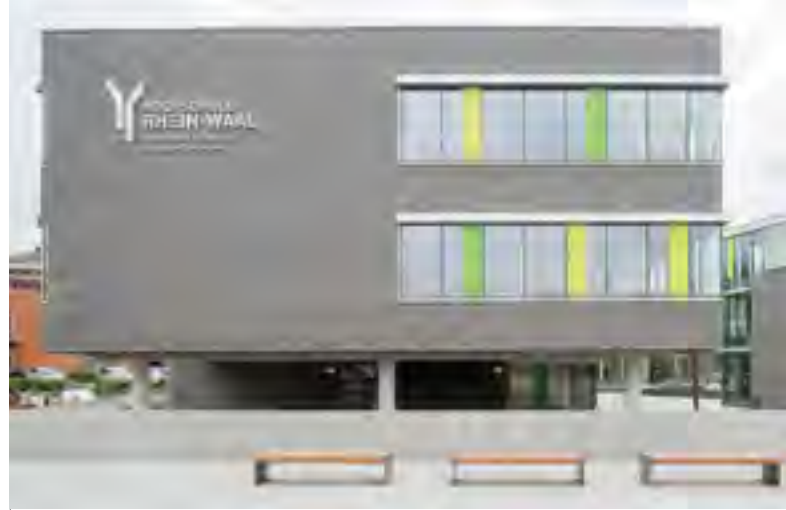
Gut zwei Jahre nach dem ersten Spatenstich können die modernen Gebäude im April 2014 eingeweiht werden.
