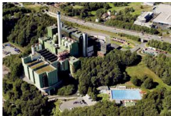
Müllheizkraftwerk awg mbH Wuppertal
