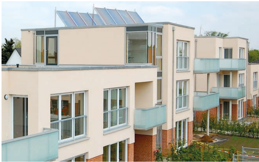
Die Solarsiedlung in Düsseldorf-Garath deckt den Großteil ihres energetischen Eigenbedarfs selbst. Sie ist eine von 50 Solarsiedlungen in Nordrhein-Westfalen.
