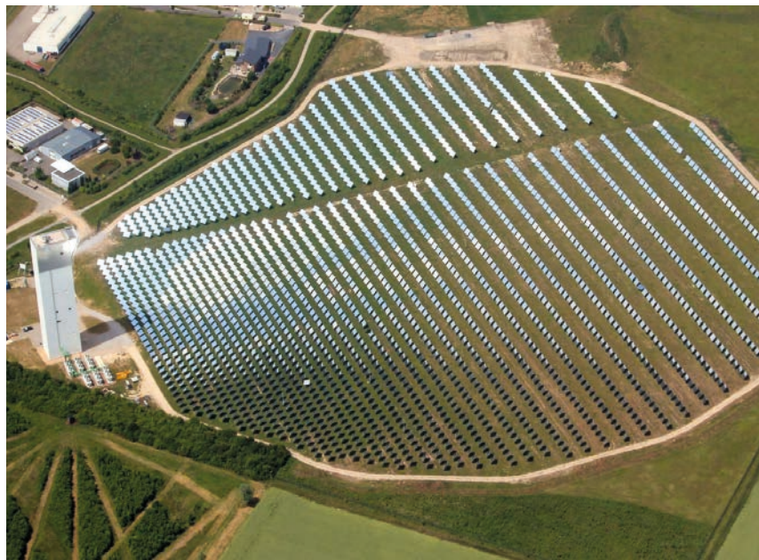
Der Solarturm in Jülich ist Vorbild für ein Projekt in Algerien
