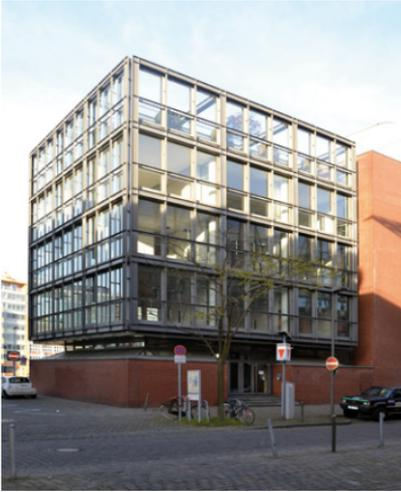
Wie ein schwebender Würfel aus Stahl und Glas wirkt das viergeschossige Bürogebäude „Kaistraße 8“ mit Dachterrasse. Der würfelförmige Teil reagiert auf die Fassade des benachbarten Hauses von RKW, der Ziegelsteinsockel sowie die fünfgeschossige rahmende Gebäudescheibe ergeben sich aus der Nachbarschaft zu dem ebenfalls von HPP entworfenen Atriumhaus.
