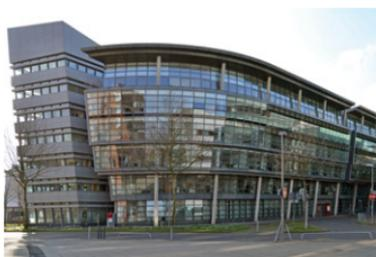
Auf einem 3.000 m<sup>2</sup> großen Grundstück entstand das bis zu sieben-geschossige Gebäude für Büros, Gastronomie und Einzelhandel mit trapezförmigem Grundriss und innenliegendem Atrium.
