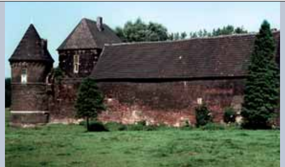
Die Seitenansicht der Burg Vondern zeigt die Rückwand der ehemaligen Remise. Dieser Gebäudeteil konnte jetzt mithilfe der NRW-Stiftung zu einem Veranstaltungs- und Ausstellungsraum ausgebaut werden.
