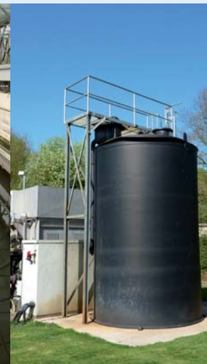
Fällmittellager und -dosierstation
