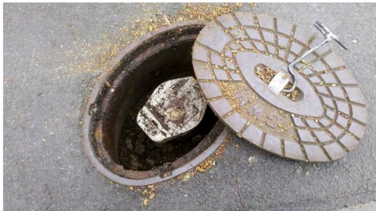
Abb. 18: Grundwassermessstelle in der Straßendecke (Quelle: LANUV NRW).
