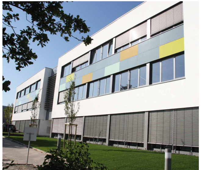
Rund 5.000 Quadratmeter stehen den Wissenschaftlern/-innen im CENTRUM INDUSTRIAL IT zur Verfügung.
