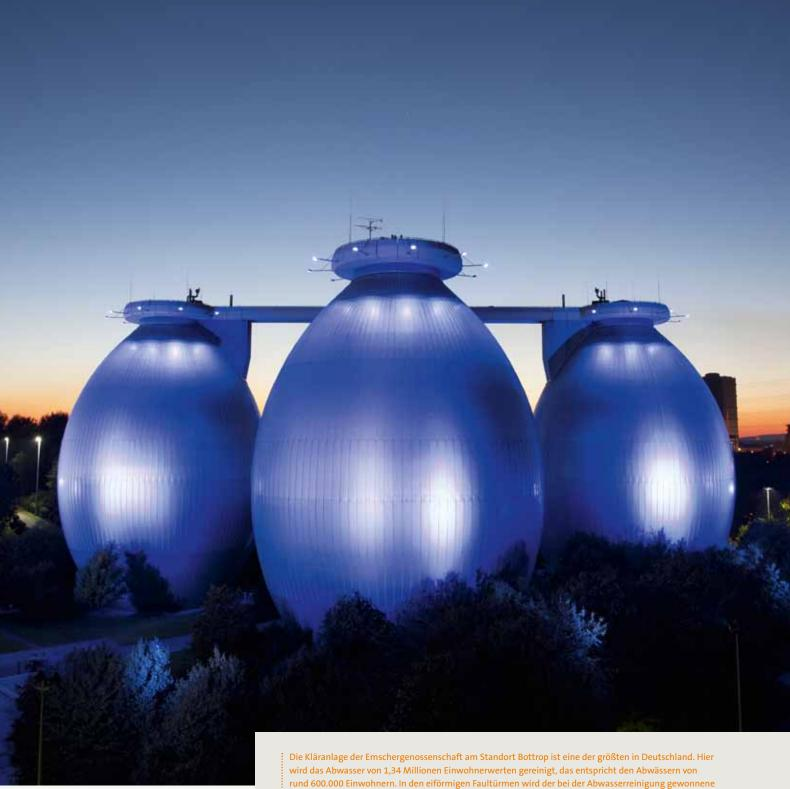
wird das Abwasser von 1,34 Millionen Einwohnerwerten gereinigt, das entspricht den Abwässern von rund 600.000 Einwohnern. In den eiförmigen Faultürmen wird der bei der Abwasserreinigung gewonnene Klärschlamm erhitzt und umgewälzt, um den Faulprozess zu beschleunigen. Mit dem entstehenden Faulgas werden rund 60 Prozent des eigenen Energiebedarfs auf der Kläranlage gedeckt.
