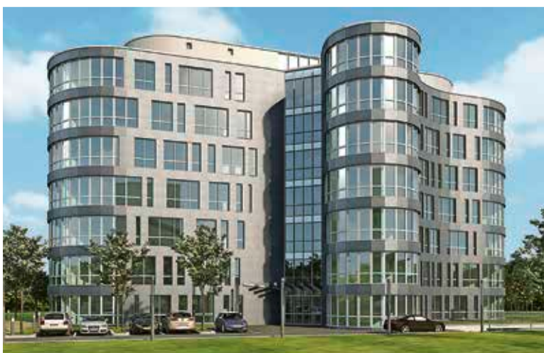
Anfang 2015 erfolgte der Baubeginn für das „Airport Office Four“, das Mitte 2015 fertig sein soll.
