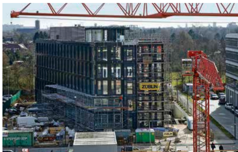
Lückenschluss in der Airport City: Zwischen Siemens und dem Porsche Zentrum wird das Bürogebäude KB4 gebaut.
