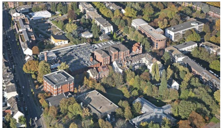
Luftbild aus dem Jahr 2008 vom Campus Mönchengladbach: Auf der Wiese oben rechts wird das Multifunktionalgebäude errichtet.
