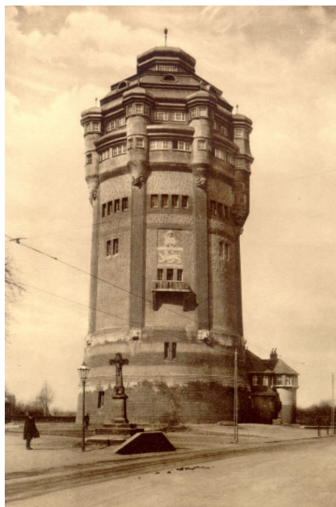
Wasserturm, um 1912 (StAMG 10/10772)
