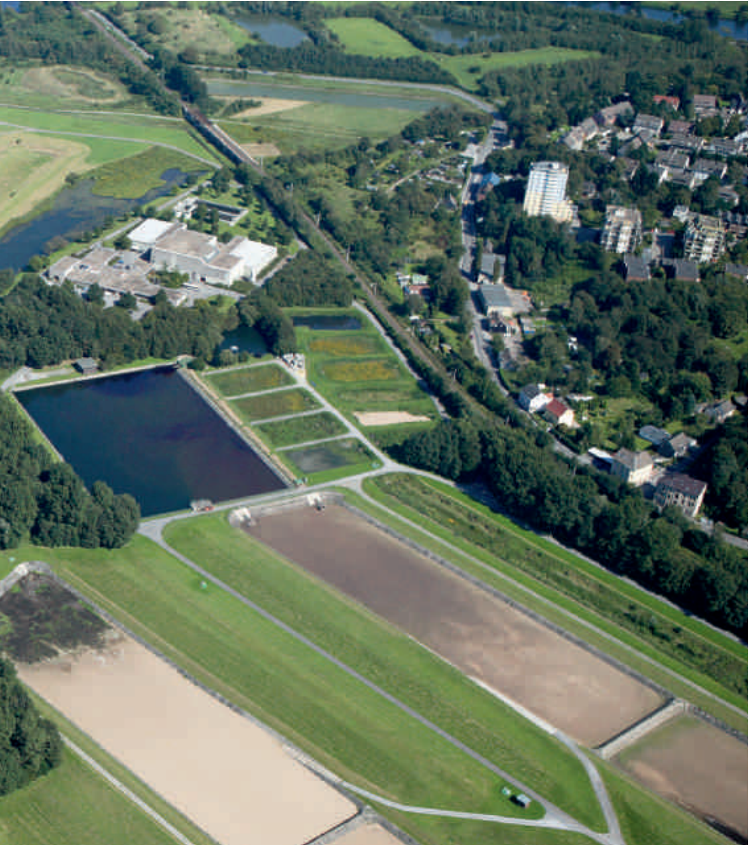
Spillenburger Wehr bei Essen-Steele und Gebäude des Wasserwerks Essen-Überruhr
