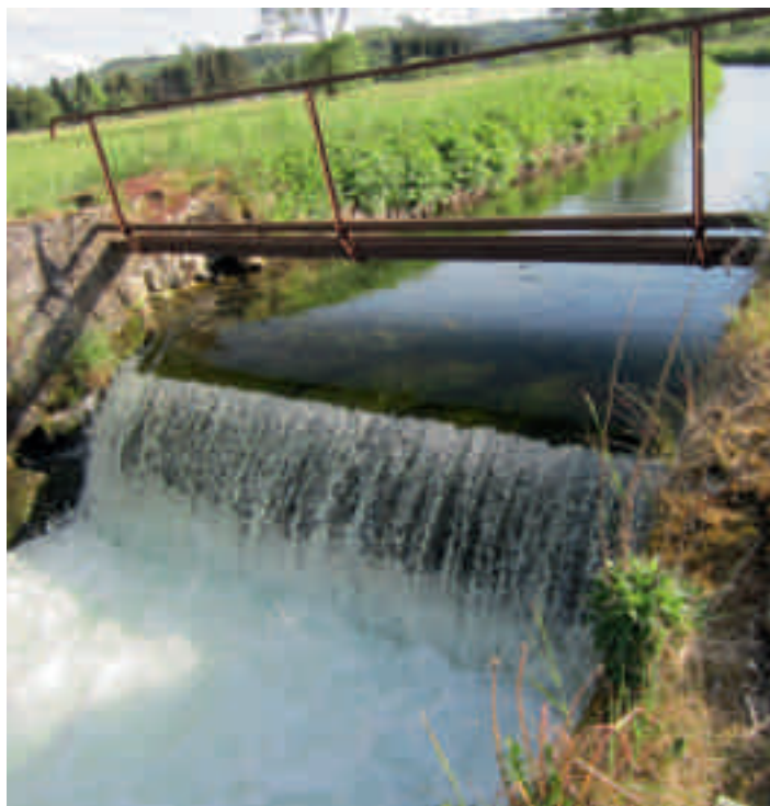
Bild 9.3: Absturzbauwerk in der Sorpe kurz vor der Einmündung in die Röhr Fig. 9.3: Weir in the River Sorpe just before its mouth into the River Röhr.
