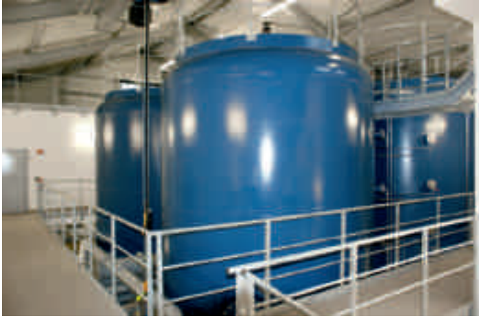
Bild 16.5: Aktivkohlefilter Fig. 16.5: Activated carbon filter
