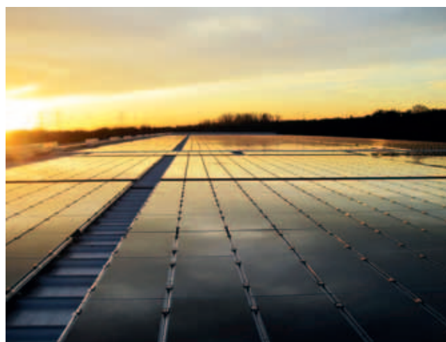
Dachfläche einer Industriehalle (1,0 Megawatt) in Castrop-Rauxel
