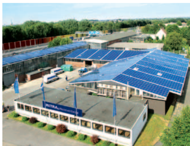
Firmengebäude in Bochum mit eigener Dachanlage
