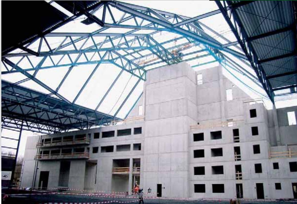
*Rohbau der neuen Halle des Instituts der Feuerwehr, in der Übungen witterungsunabhängig durchgeführt werden können.*
