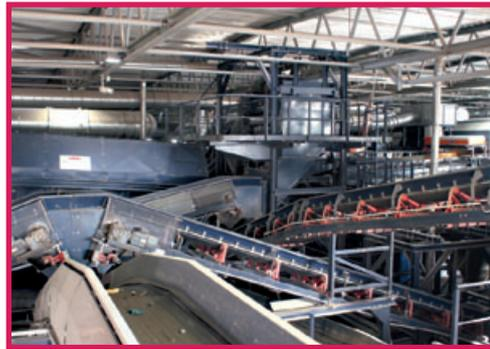
Einige Kommunen besitzen eine mechanisch-biologische Restabfallbehandlungsanlage (MBRA). Die Bilder zeigen die Anlage in Münster. Nach einer ersten Kontrolle des Mülls erfolgt die mechanische Aufbereitung, d. h. eine Zerkleinerung und Trennung der Bestandteile. Anschließend beginnt die biologische Behandlung der Reste. Weitere Informationen zu der Anlage finden Sie unter [www.awm.stadt-muenster.de](http://www.awm.stadt-muenster.de)
