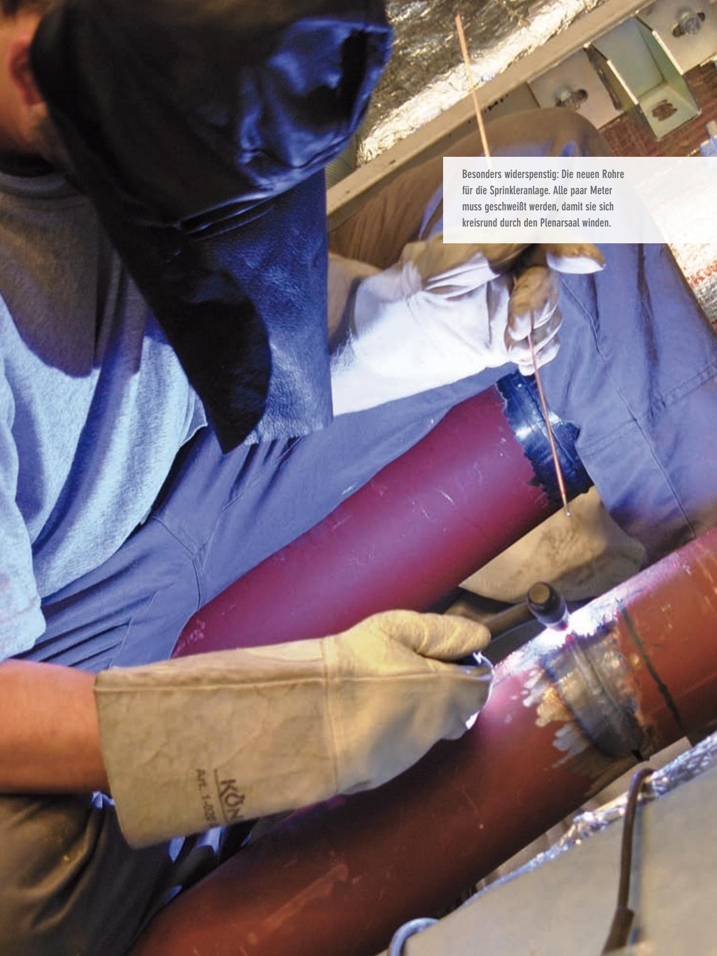
Besonders widerspenstig: Die neuen Rohre für die Sprinkleranlage. Alle paar Meter muss geschweißt werden, damit sie sich kreisrund durch den Plenarsaal winden.
