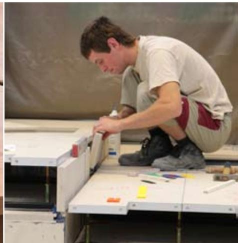
**W**ährend im Plenarsaal weiter die Abgeordnetentische montiert werden, beginnt die Verlegung des bereits mit Teppichboden beklebten oberen (reversiblen) Bodenplatten. In einem weiteren Schritt werden außerdem wichtige Installierungen vorbereitet. So werden nun nach und nach die Tische an das Strom- und Lüftungsnetz angeschlossen sowie die Anschlüsse für die Mikrofone gelegt.
