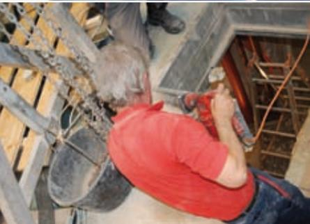
**D**er Plenarsaal gleicht in diesen Tagen einem Bienenstock: An allen Ecken und Enden summt und brummt es unaufhörlich. Eine Stahlschraube nach der anderen verschwindet im nackten Saalboden, die ersten bereits verlegten Klimakanäle erhalten rechts und links jeweils einen kreisförmigen Ausgang mit aufgesetzten Schläuchen. Diese verteilen bald die Frischluft zu den einzelnen Tischen der Abgeordneten.
