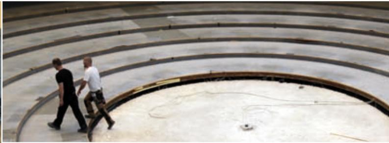
Nachdem Stühle und Tische verschwunden sind, geht es an den Bodenbelag: Der Teppich muss raus. Denn darunter befindet sich die veraltete Belüftungsanlage. In Zukunft soll die frische Luft nicht länger durch den Teppich, sondern direkt durch kleine Öffnungen in den Tischfronten strömen.
