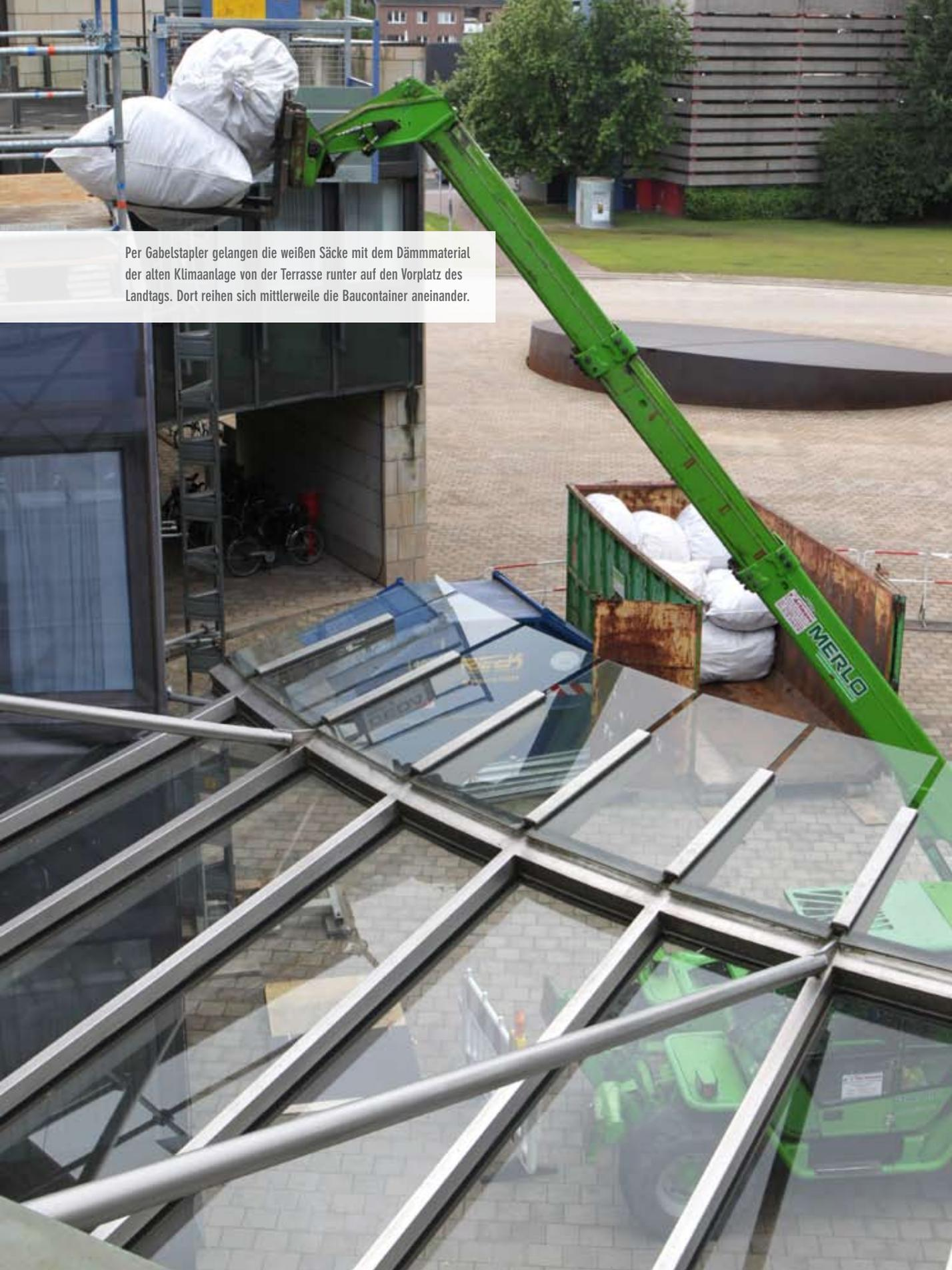
Per Gabelstapler gelangen die weißen Säcke mit dem Dämmmaterial der alten Klimaanlage von der Terrasse runter auf den Vorplatz des Landtags. Dort reihen sich mittlerweile die Baucontainer aneinander.
