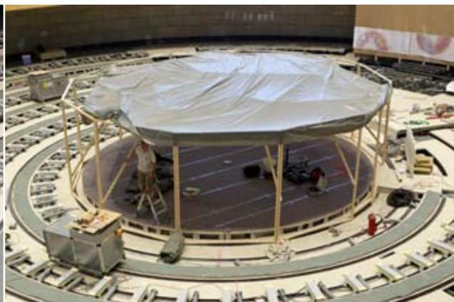
In der vergangenen Woche wurde bei der Sanierung des Plenarsaals eine wichtige Phase abgeschlossen: Die untere Bodenebene, in die auch das neue Belüftungssystem integriert ist, konnte fertiggestellt werden. Jetzt können die Aufbauten, Tische und Stühle, in Angriff genommen werden. Hierzu werden in den nächsten Tagen noch notwendige Elektroleitungen verlegt. Ab Mitte der Woche geht es dann um das Mobiliar, an dem die Abgeordneten bald wieder über landespolitische Themen debattieren.
