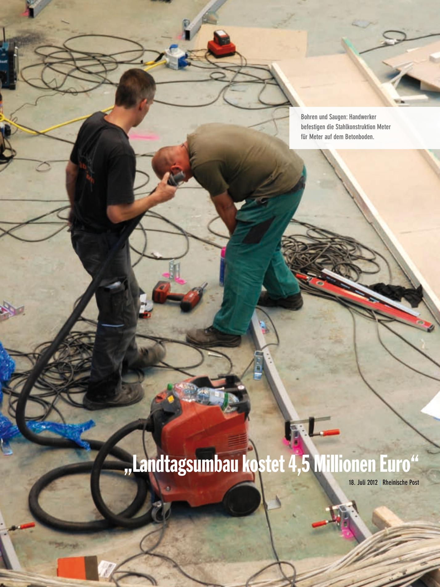
Bohren und Saugen: Handwerker befestigen die Stahlkonstruktion Meter für Meter auf dem Betonboden.
