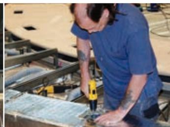
Die Klimaanlage hält noch viel Arbeit bereit. Ein Arbeiter montiert die seitlichen Ausgänge für die Lüftungsschläuche.
