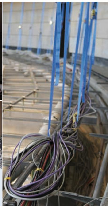
**T**ag sechs der Sanierung beginnt. Die Handwerker treffen die letzten Vorbereitungen, um die fast 25 Jahre alte Klimatechnik ausheben zu können. Dazu wird die gesamte Stahlkonstruktion verschwinden, die dem Plenarsaal bislang ihren terrassenförmigen Charakter gab. Große Schläuche zur provisorischen Entlüftung führen schon jetzt von der Wandelhalle bis ins Untergeschoss (Bild auf der rechten Seite).
