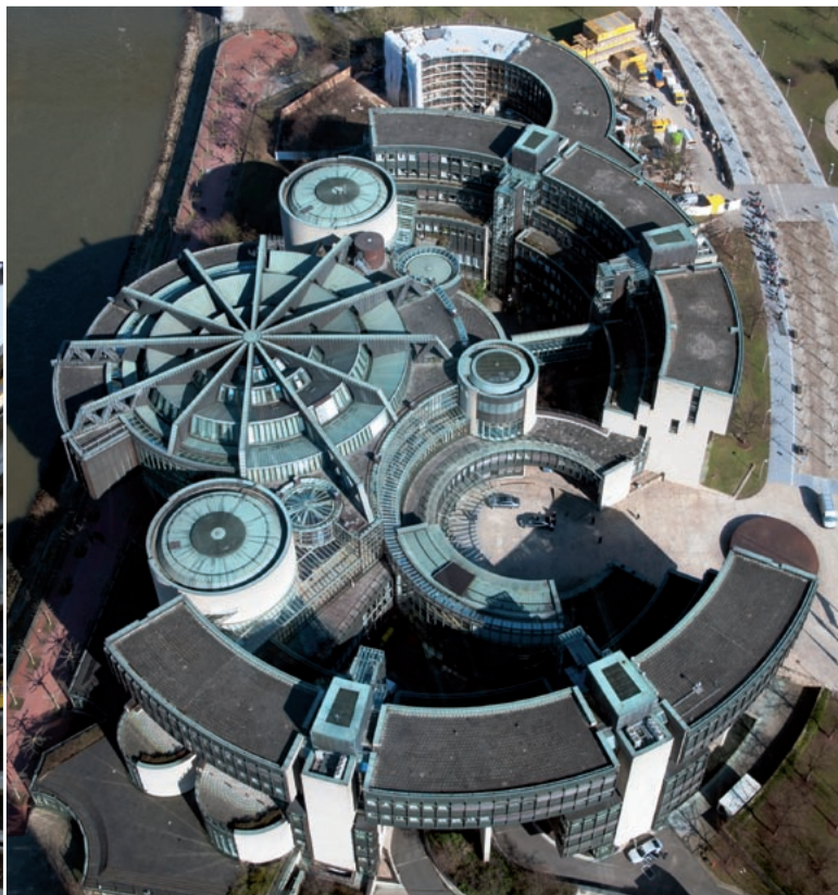
Blick auf den Anbau im Rohbau, 10. März 2010
