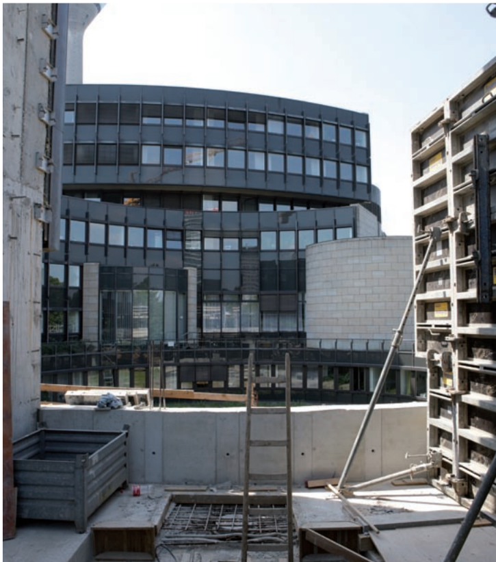
Blick aus der Baustelle des Anbaus, 20. August 2009
