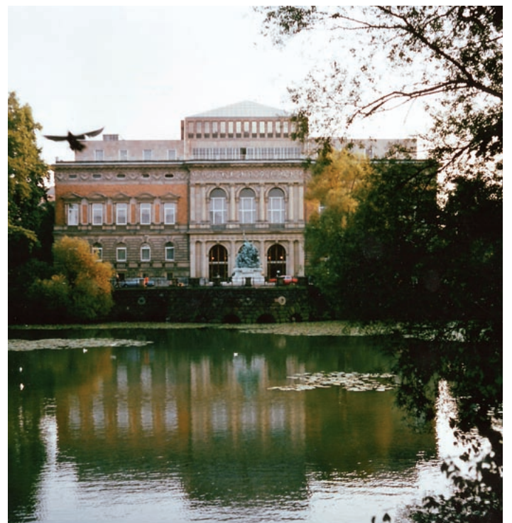
Vorderansicht nach dem Dachausbau des Ständehauses, 1980
