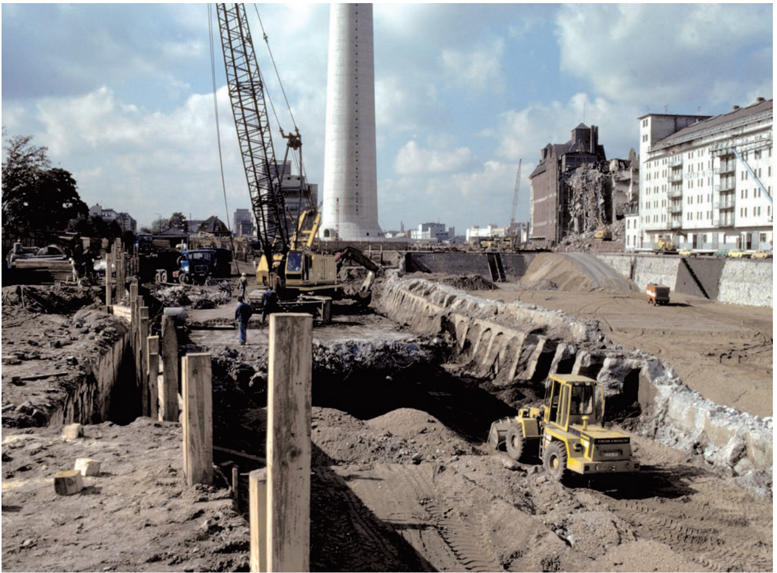
Baugrube, Abbruch der Mole auf der Stadtseite mit Blick auf den Fermmeldeturm und das Hafengebäude von Fortin und Rhenus, 1981
