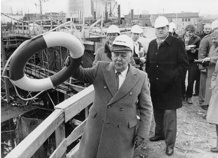
Landtagspräsident van Nes Ziegler bei der Besichtigung der Baustelle vor dem „gefluteten“ Plenarsaal, Februar 1983
