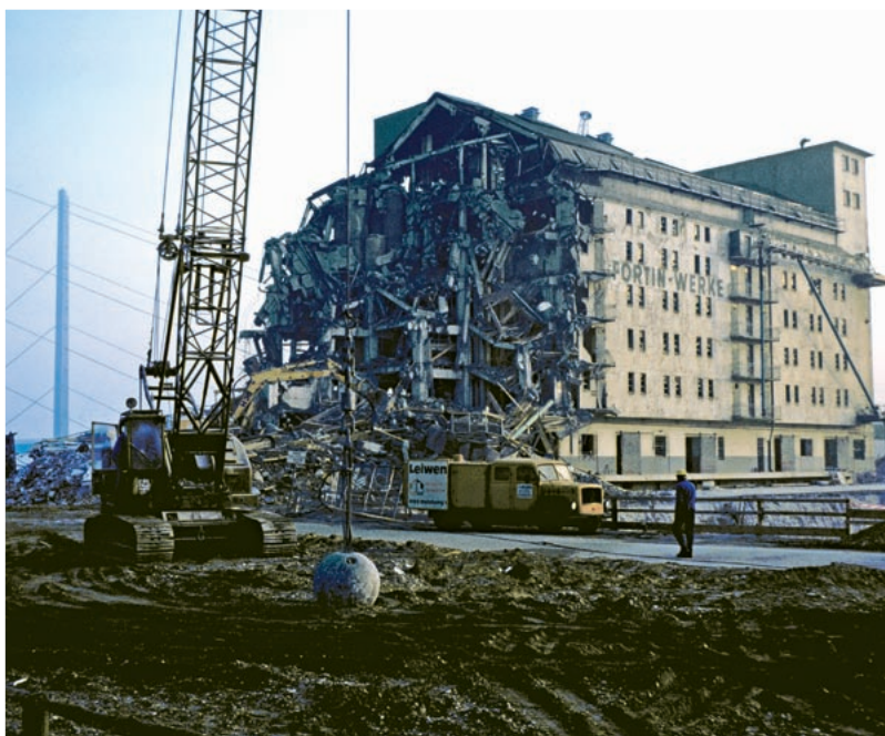
Abbruch der Hafengebäude: Getreidemühle Fortin an der Stelle des heutigen Plenarsaals, 1981
