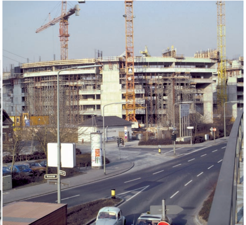
Rohbau von der Hochstraße aus gesehen, 1983
