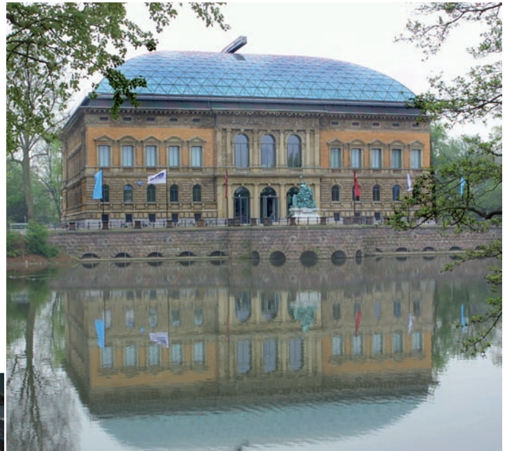
Kunstsammlung K 21 – Ständehaus nach dem Umbau
