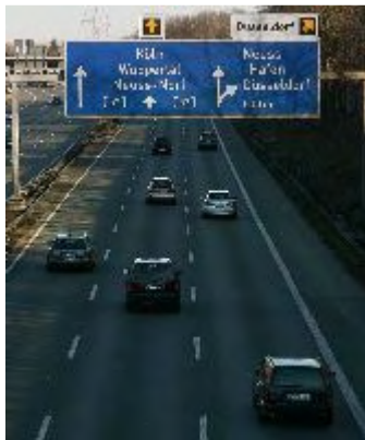
Abb. 6-4: Beispiel für die dynamische Wegweisung mit DMotion (Quelle: WZ Newline vom 13. 03.2008)
