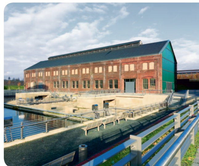
Turbinenhalle, Bochum, Foto: Engels & Krämer GmbH
