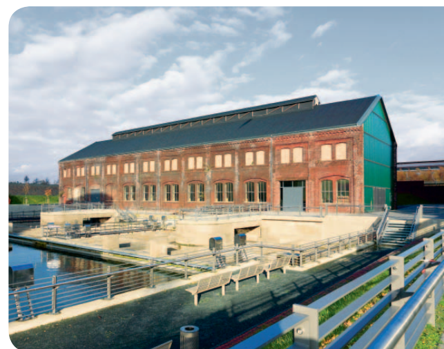
Turbinenhalle, Bochum, Foto: Engels & Krämer GmbH
