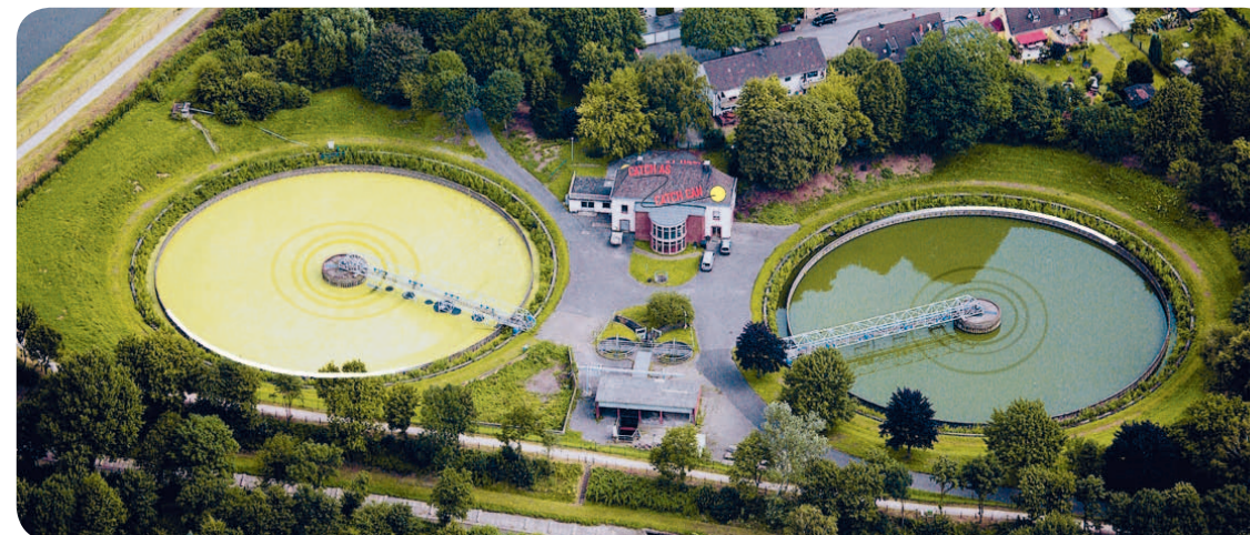
Umgestaltete Klärbecken der ehemaligen Kläranlage Bernemündung, Entwurf: Piet Oudolf und Eelco Hooftman
