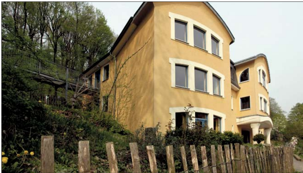
Auch die Troxlerschule hat nun eine Chance auf energetische Sanierung
