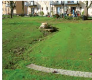
*Eine Kombination aus Versickerung (links und rechts), Retention (Mitte) und gedrosselter Ableitung in offenen Rinnen machen in der Welheimer Mark die Abkopplung des Regenwassers von der Kanalisation möglich und setzen gestalterische Akzente.*
