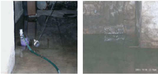
Abb.4 Situationen in Kellern
