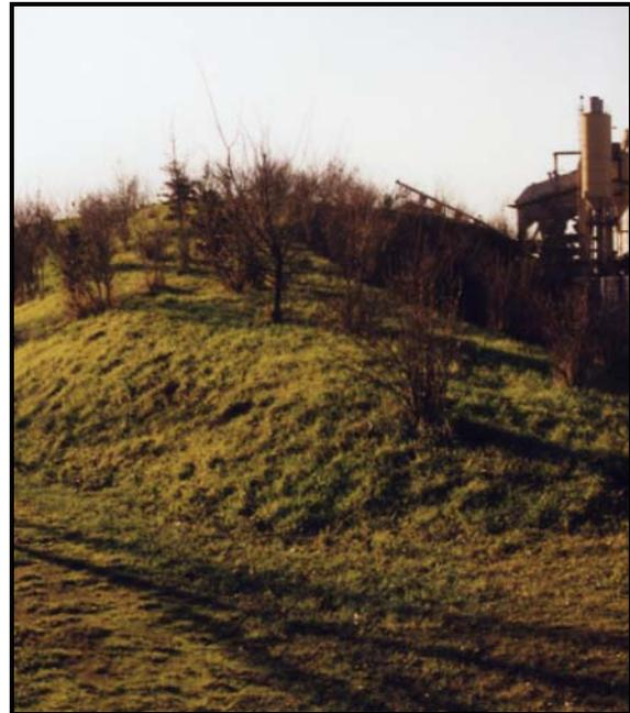
*Begrünter Immissionsschutzwall bei einer Bitumenmischanlage*
