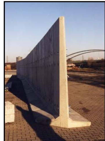
*Die Lagerbereiche sind grundsätzlich durch Stellwände oder ähnliches abzugrenzen. Bei großen homogenen Halden (z.B. Kohlehalden > 10.000 t), bei stückigem Material und bei Bereichen, bei denen die Oberflächen mit Matten abgedeckt sind oder eine Begrünung vorhanden ist, kann davon abgesehen werden.*
