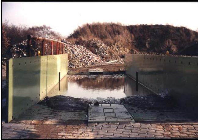
*Einfaches Durchfahrbecken mit Zwangsführung bei einer Bauschutttaufbereitung*
