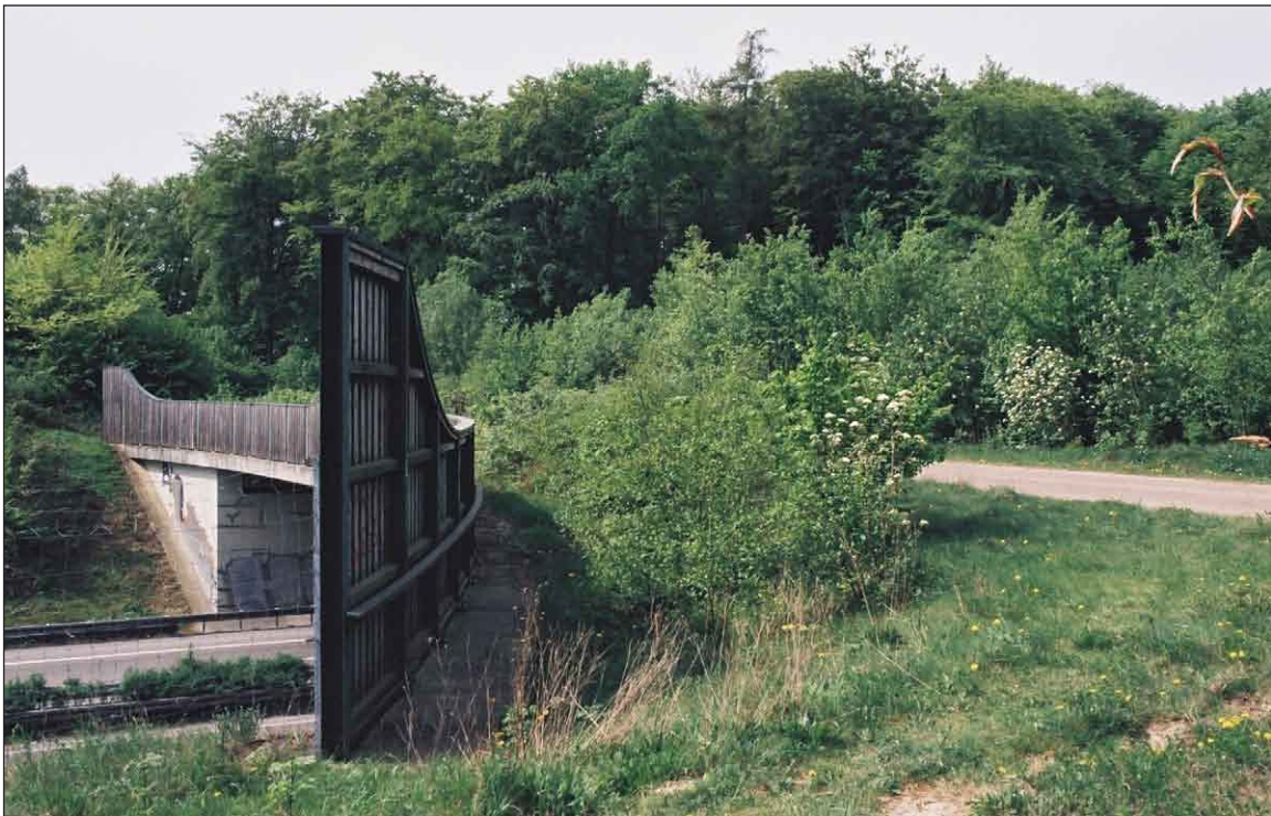
Abb.7: Häufige Mängel bei Grünbrücken sind die mitgeführten Wege und Straßen und eine zu geringe Breite – wie auch in diesem Beispiel der Grünbrücke über die A 33 bei Hilte im Teutoburger Wald.
