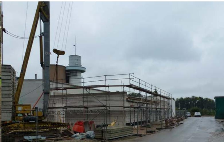
Klärgasspeicher mit einem Volumen von 500 m<sup>3</sup> einer Intensivprüfung unterzogen. In diesem Rahmen wurde die Gummimembrane ausgetauscht und eine vollständige Innenneubeschichtung realisiert.
