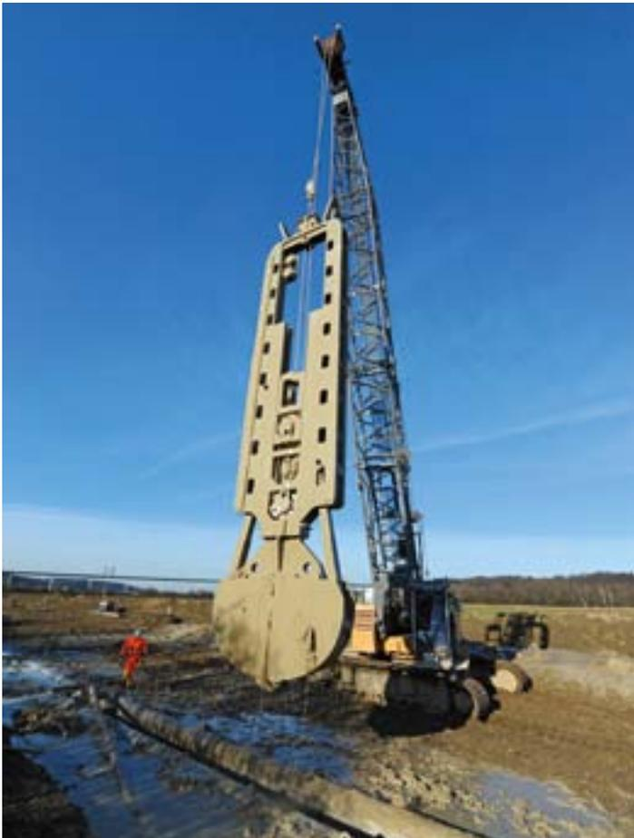
Bild 19.4: Schlitzgreifer im Einsatz
