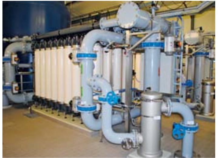
Bild 17.6: Membranmodule
