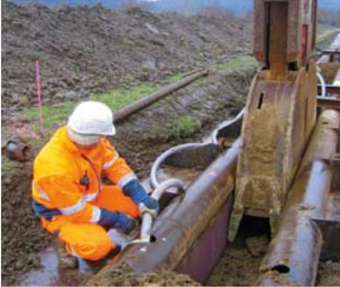
Bild 19.3: Errichtung der Leitwände
