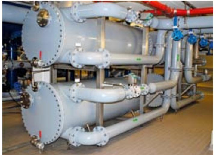
Bild 17.3: Reaktionsbehälter
