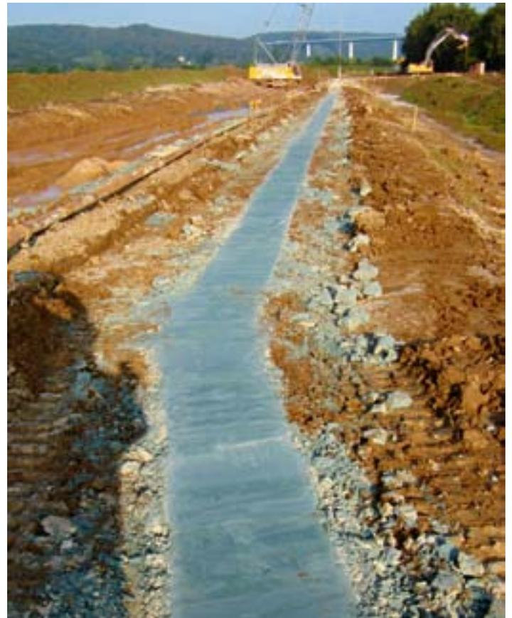
Bild 19.5: Abgeschälter Dichtwandkopf
