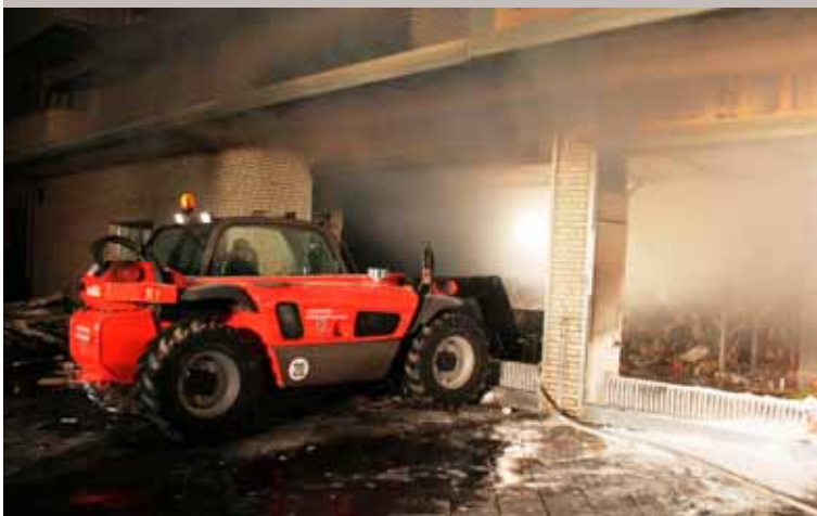
Vom THW wurde in mühevoller Arbeit an der Gebäuderückseite eine Öffnung geschaffen, durch die mit Hilfe eines Mini-radladers das Brandgut aus diesem Teil des Gebäudes geschafft werden konnte. An der Vorderseite wurde das Brandgut mit Hilfe eines Mantous, Schubkarren, Hubwagen usw. entfernt.
