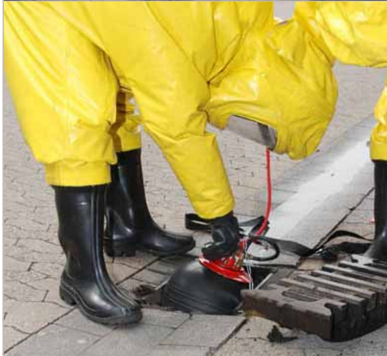
Auffangen der auslaufenden Flüssigkeit und Dichtsetzen der Kanalisation...
