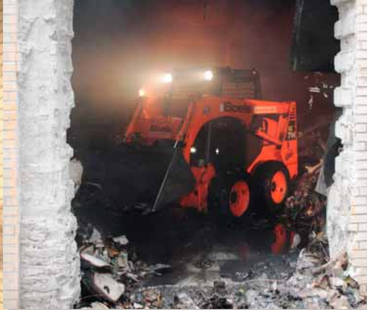
Vom THW wurde in mühevoller Arbeit an der Gebäuderückseite eine Öffnung geschaffen, durch die mit Hilfe eines Mini-radladers das Brandgut aus diesem Teil des Gebäudes geschafft werden konnte. An der Vorderseite wurde das Brandgut mit Hilfe eines Mantous, Schubkarren, Hubwagen usw. entfernt.
