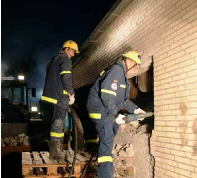
Vom THW wurde in mühevoller Arbeit an der Gebäuderückseite eine Öffnung geschaffen, durch die mit Hilfe eines Mini-radladers das Brandgut aus diesem Teil des Gebäudes geschafft werden konnte. An der Vorderseite wurde das Brandgut mit Hilfe eines Mantous, Schubkarren, Hubwagen usw. entfernt.
