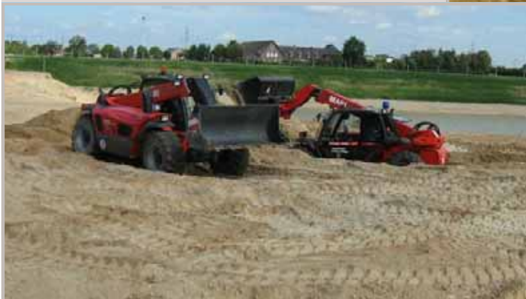
Manitou beim Ausheben einer Grube
